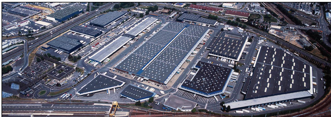
Figure 84 – Photo de la plateforme SOGARIS, Rungis, © Marc Beaudenon / DR Sogaris
