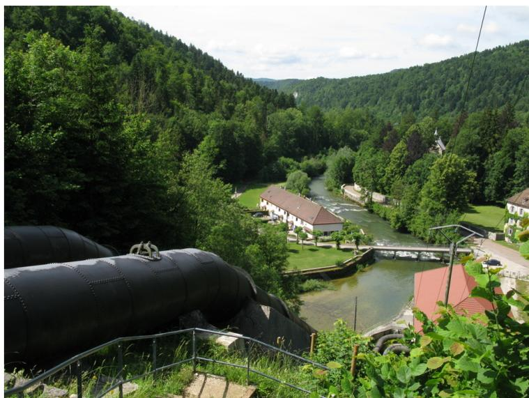
**FIGURE 8.16** – Les conduites et la centrale EDF de Bourg-de-Sirod (Cliché : S. Flaminio, juin 2015). Cette centrale d'abord mise en service en 1922 est aujourd'hui concédée à EDF. Elle est exploitée au fil de l'eau malgré son importante hauteur de chute (48 mètres), une galerie souterraine d'aménée de 400 mètres de long et des conduites forcées atteignant 100 mètres de longueur. Elle dispose d'une puissance installée de 5 MW.
