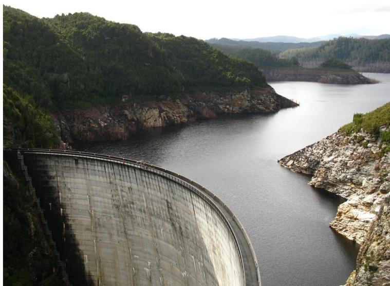
**FIGURE 3.14** – Le barrage Gordon, pièce maîtresse du *Gordon river power development stage 1* (Cliché : S. Flaminio, août 2014). Le barrage Gordon est le 5<sup>e</sup> ouvrage le plus haut d’Australie et le premier ouvrage par son volume (12 milliards de m<sup>3</sup>).
