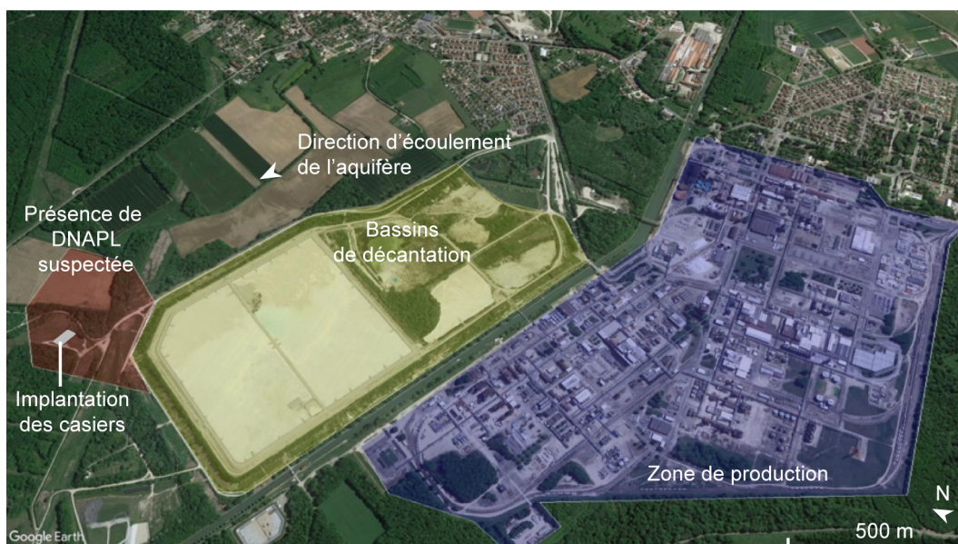
Figure 2.8: Vue aérienne du site industriel de Tavaux (Crédits photo : Google).
