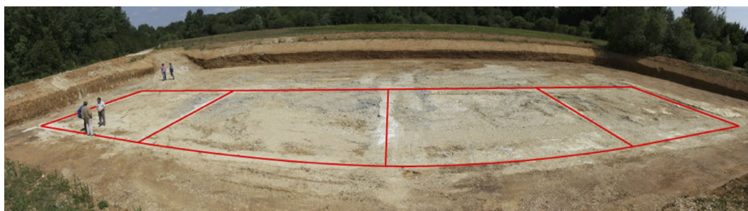
Figure 2.10: Photographie panoramique des quatre casiers étanches vus depuis la surface. Tous font 10 m de côté et leurs parois imperméables s'ancrent dans le substratum argileux (Crédits photo : Q. Giraud).
