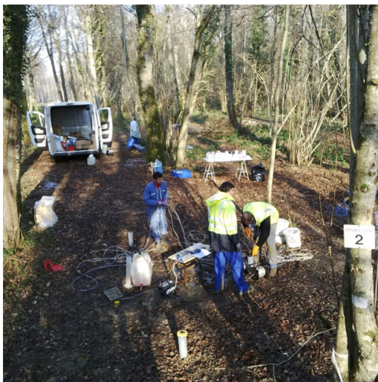
Figure 2.11: Photographie de l'installation pour l'expérimentation au niveau du panache. Au premier plan, les piézomètres aval d'une des deux zones expérimentales (Crédits photo : A. Joubert).
