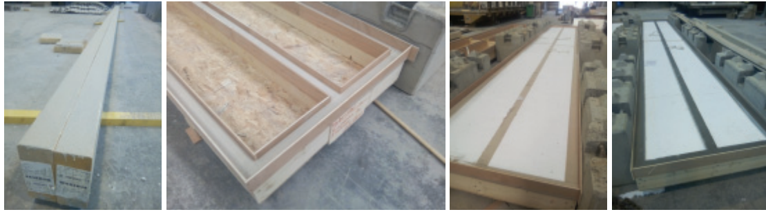
Figure V-35 : Processus de fabrication des planchers de l'usinage des poutres bois jusqu'à la construction du module avant coulage du béton
