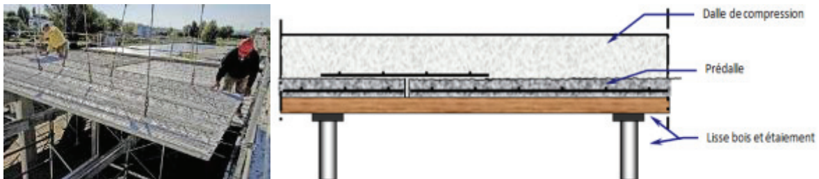
Figure II-7 : Plancher à prédalle
