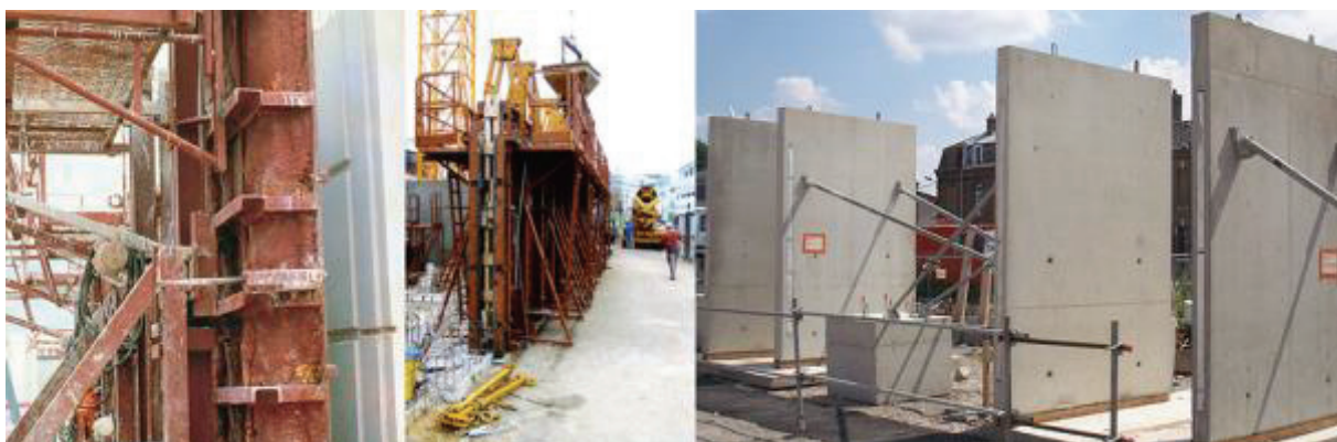
Figure II-30 : Voile en BA, avec système de banches (gauche) et après démolage (droite)
