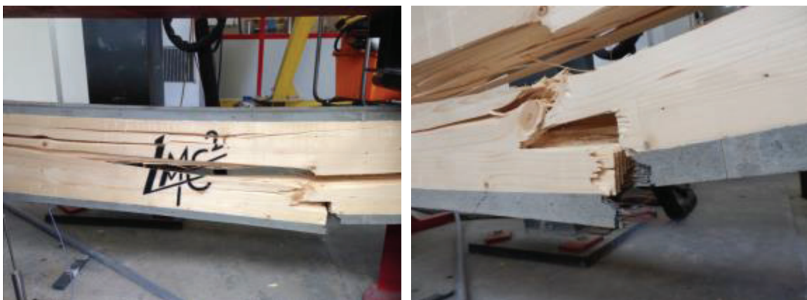
Figure V-17 : Rupture de la poutre C_1
