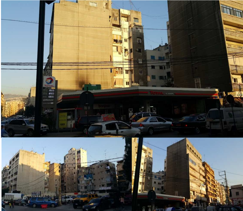
Figure 3.2: Photos du quartier à Dora montrant les bâtiments et les routes.
