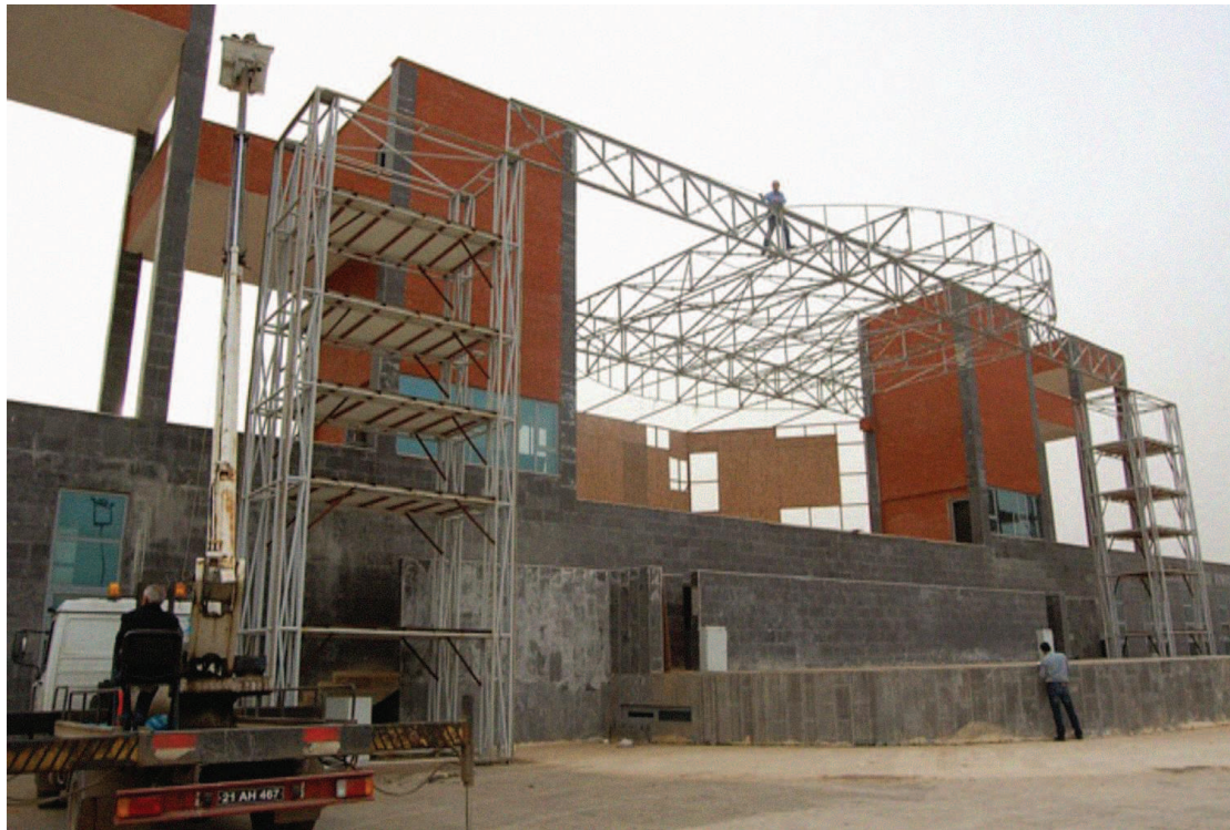
Légende : construction de la structure qui accueille les speakers et les artistes lors du Newroz. Elle est située à l'extrémité du Parc. © Baglar Belediyesi.
