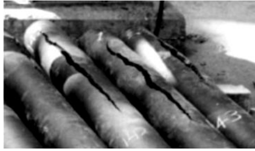
Fig. I.14 Fissures longitudinales dans les tubes de vaporereformage [Gar11]
