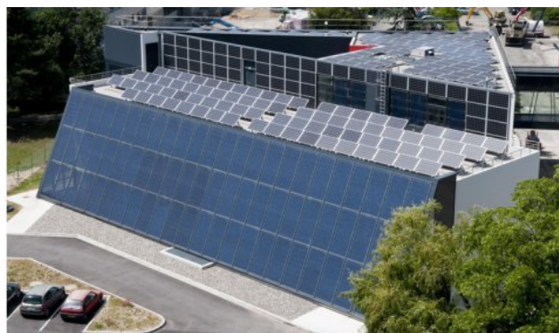
FIGURE 4.7 – Le bâtiment ADREAM, au LAAS-CNRS de Toulouse
