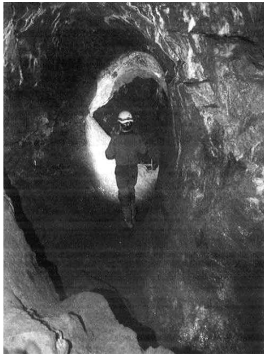
Figure 490 : Oiartzun, Arditurri 20, Urteaga et Ugalde 2011, fig. 20, p. 555, Galerie de la mine d'Arditurri 20 avec des traces d'abattage au feu.
