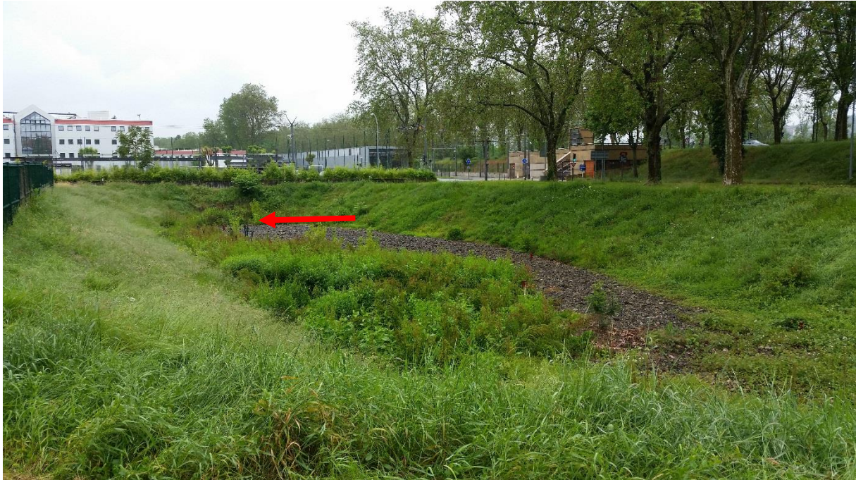
Figure 7 : Bassin d'infiltration du campus de la Doua – Villeurbanne (Photographie : Marie Morin). La flèche rouge indique le lieu de prélèvements des rejets.
