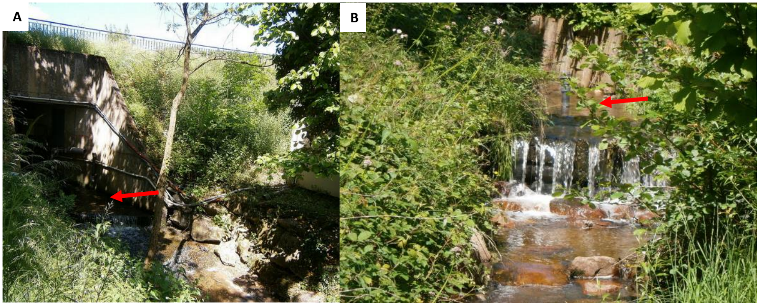
Figure 10 : Déversoir d'orage situé à Grezieux-la-Varenne (A) et de la Chaudanne dans laquelle les rejets se déversent (B) (source : OTHU). Les flèches rouges indiquent les lieux de prélèvements des rejets.
