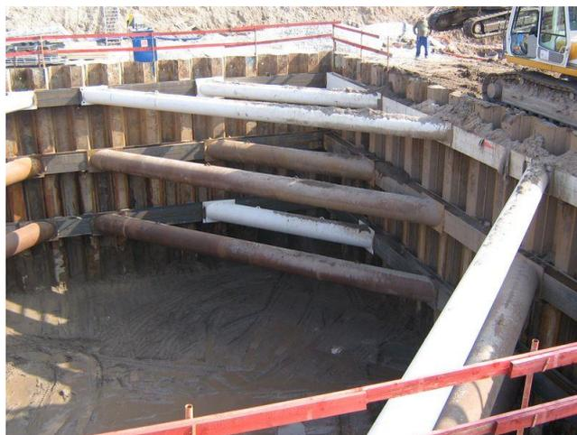
**Figure I.6.** Appui par buton (Tecs, 2009)
