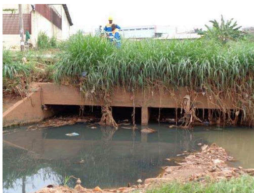
Figure 45 : Pont sur le Mfoundi au niveau de Sofavinc (Mfoundi2) (Catherine Gonzalez, 2015)
