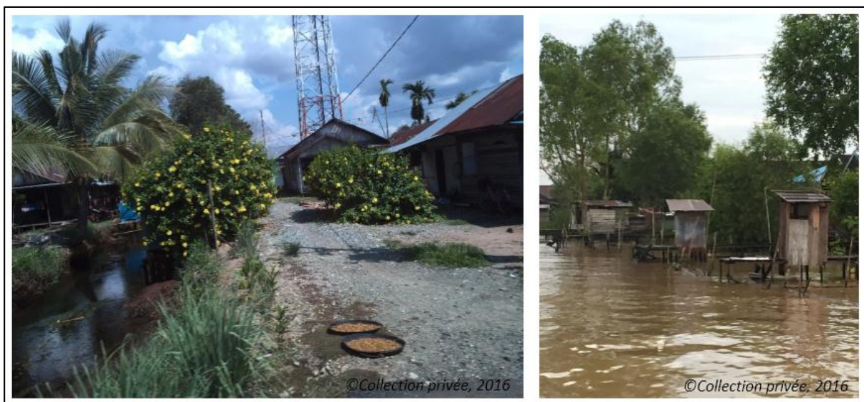
Figure 64. Les maisons et les toilettes séparées. Les maisons ont été construites à environ 3 mètres des rivières (à gauche) tandis que les toilettes se sont installées sur le canal (à droite). Tabunganen, 2016.
