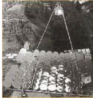
Figure I-4 : Centrale à focalisation poncutelle construite à Sant’Ilario en 1965. <sup>[10]</sup>
