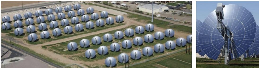
Figure I-10 : Centrale parabolique Maricopa. Vue générale à gauche et une parabole à droite. <sup>[43]</sup>
