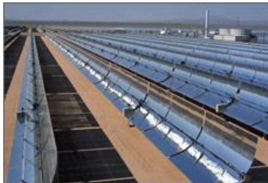
Figure I-8 : Centrale cylindro-parabolique SEGS VII. <sup>[37]</sup>
