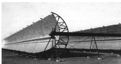
Figure I-3 : Centrale solaire installée en Égypte en 1913.
