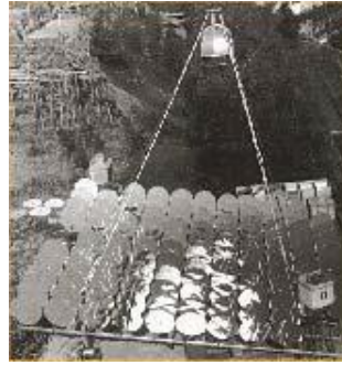
Figure I-4 : Centrale à focalisation poncutelle construite à Sant’Ilario en 1965. [10]
