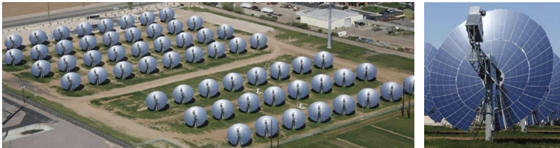
Figure I-10 : Centrale parabolique Maricopa. Vue générale à gauche et une parabole à droite. [43]
