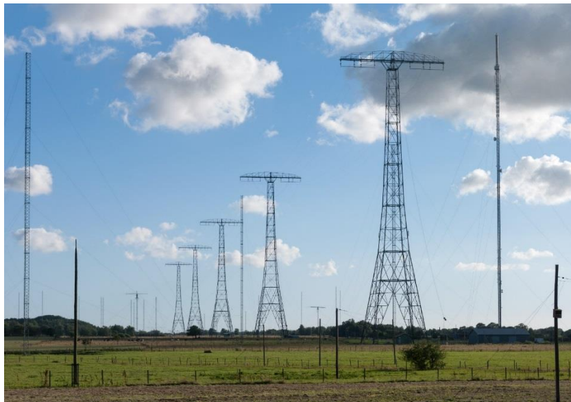
Figure 9 : L'antenne VLF et l'antenne HF de Grimeton
