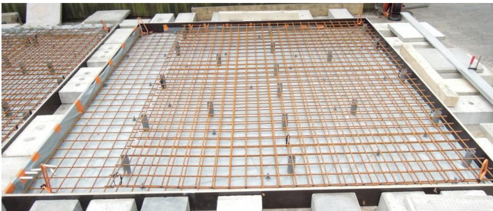
Figure III-1 : Photo de la dalle à épaisseur d'enrobage constante
