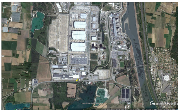
(a) (1) - Centrale Nucléaire
