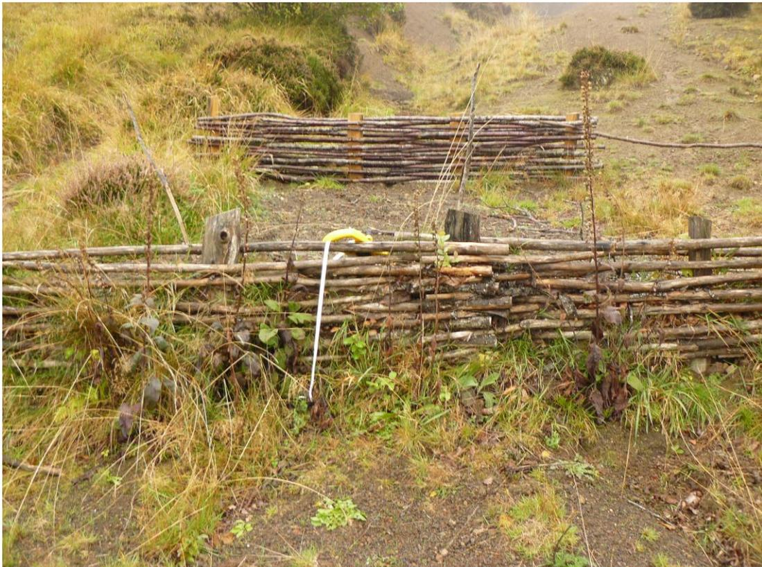
Fig. 95. Photos des fascines en bois mises en place à la sortie du cône de déjection de la ravine du Petit Puy de Dôme.
