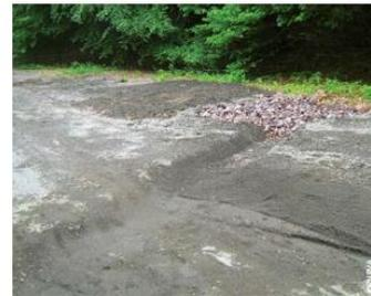
Renvoi d'eau naturel (ou tranchée à merlon) se déversant dans le puits perdu (Chemin des Gravouses)
