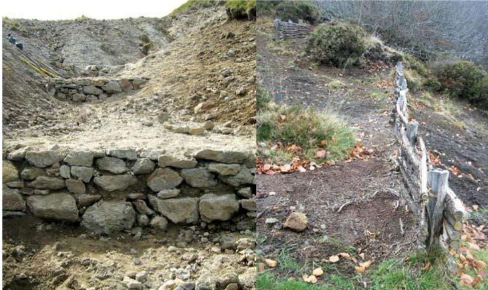
Fig. 8. Murets en pierre (ravine latérale du sentier sud-est du Sancy) et fascine en bois (au pied de la ravine du Petit Puy de Dôme dans la Chaîne des Puys) (PNR des Volcans d'Auvergne, 2013).
