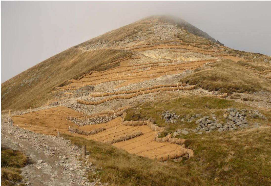
Fig. 108. Photo des aménagements du sentier sud-est du Sancy réalisés au cours de l'été 2015.
