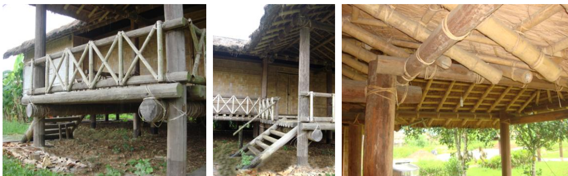
Figure 4.13 : Structure et matériaux de la maison type 2 'HDRUNG' (type des maisons de la minorité Jarai aux villages traditionnelles Viet Nam, province de Ba Vi)*.
