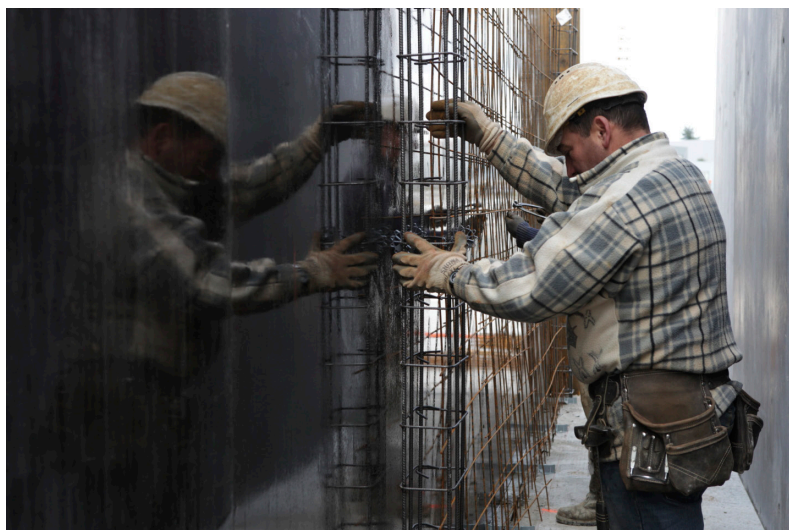
— fig. 03 Chantier du collège de Monflanquin, travail de ferrailage, Genius Loci Monflanquin.
