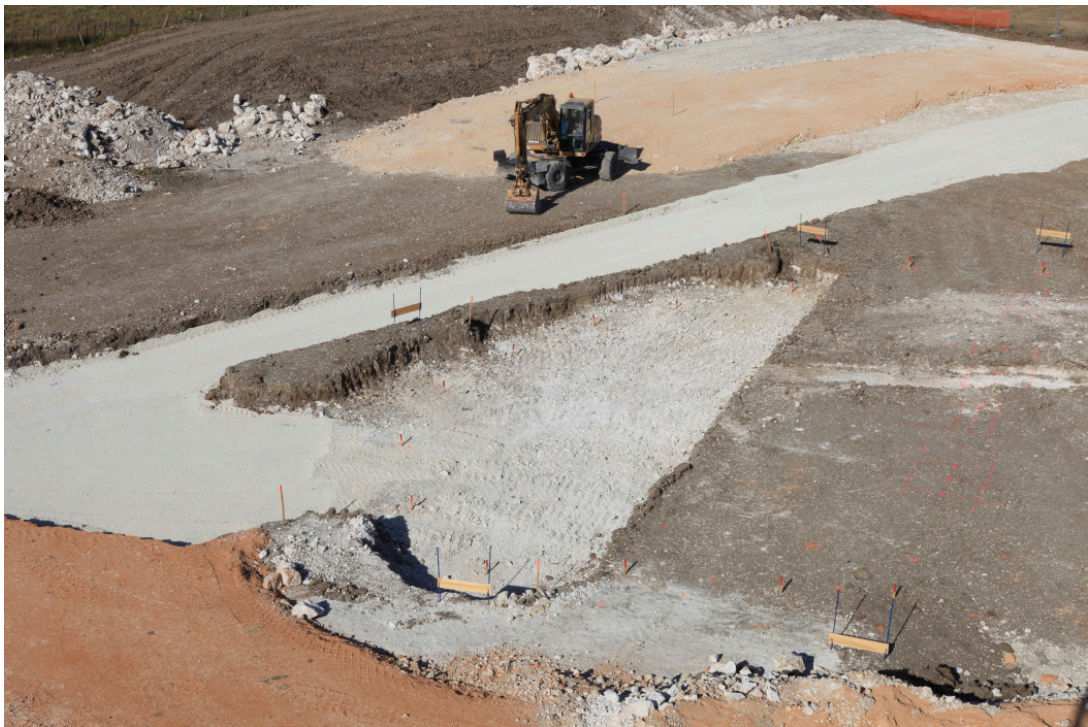
— fig. 01 Chantier du collège de Monflanquin, terrassement, Genius Loci Monflanquin.
