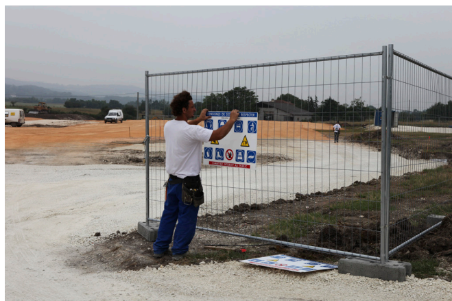
— fig. 03 Installation du panneau "chantier interdit au public". Genius Loci Monflanquin.
