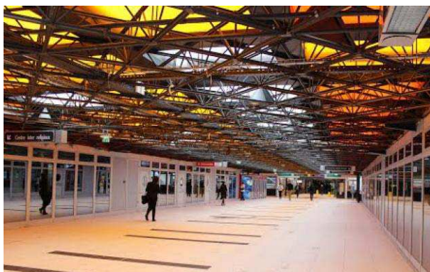
Figure 9.38 : Passage couvert de la gare de Perrache (1976, René Gagès), Lyon 2 ème (69).
