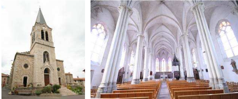
Figure 5.12 : Voûte d'ogives, église Saint-Pierre-aux-Liens (1869-1871 chœur et 4 travées Charles Antoine Favrot - 1896-1899 1 travée et clocher C.F. Meley), Estivareilles (42).
