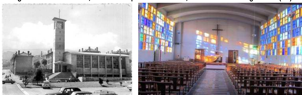
Figure 4.26 : Église du Bon Pasteur, démolition prévue en 2019, Le Chambon-Feugerolles (42).
