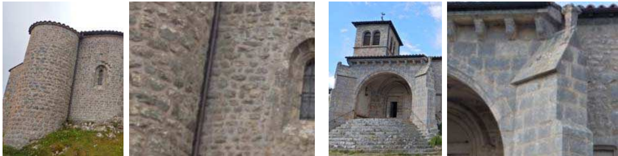
Figure 7.19 : Gros œuvre en fonction de l'époque de construction: chœur du XII e et porche du XVII e siècle.
