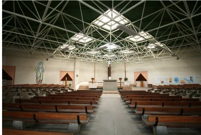
Figure 9.37 : Église Notre-Dame-de-l'Espérance, vue de la nef depuis l'entrée, Villeurbanne.
