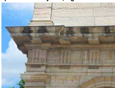
Figure 8.36 : Détails de la façade en pierres de Seyssel, église Saint-Nicolas, Givors.
