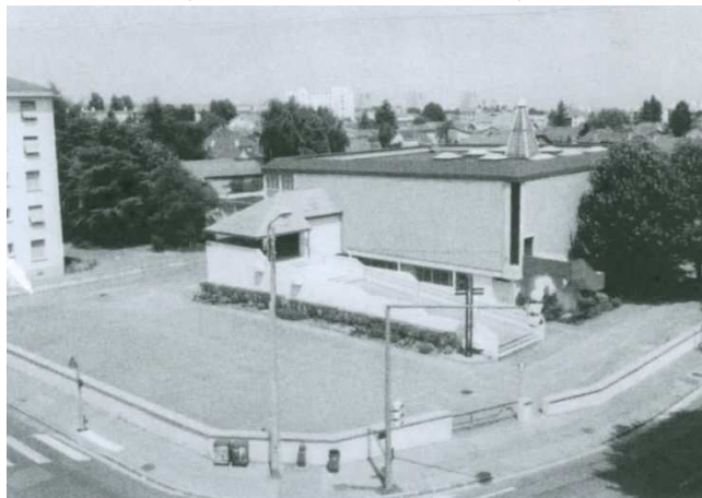
Figure 9.50 : Église Notre-Dame-de-l'Espérance, vue d'ensemble après travaux d'étanchéité.
