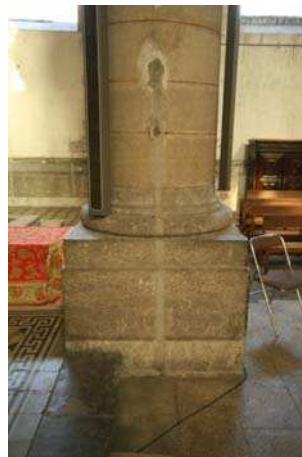
Figure 8.40 : Trace de l'enceinte du chœur sur un poteau, église Saint-Nicolas, Givors.
