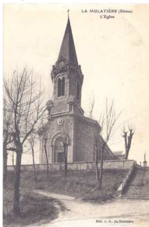
Figure 4.15 : Église Notre-Dame-de-l'Assomption démolie en 1978, La Mulatière (69).
