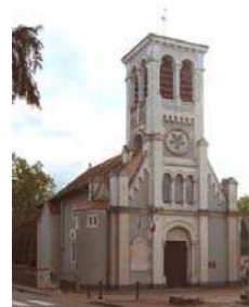
Figure 4.54 : Église Saint-François-Régis (XVII e -1880 une travée de façade), Veauchette (42).
