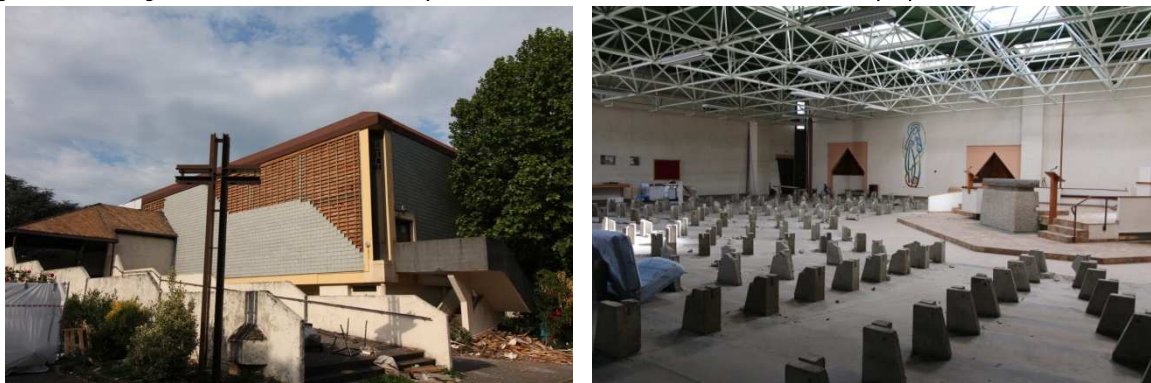
Figure 4.25 : Église Notre-Dame-de-l'Espérance démolie en 2018, Villeurbanne (69).
