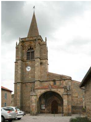
Figure 3.4 : Église Saint-Irénée (1529), CMH 1973, Luriecq (42).
