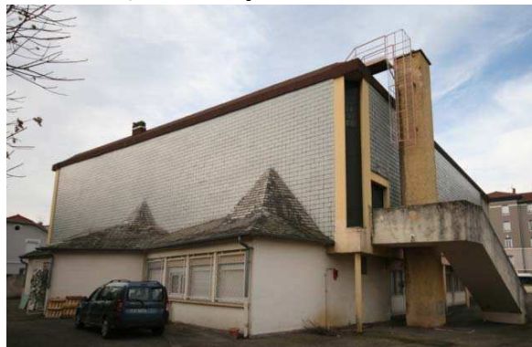
Figure 9.45 : Église Notre-Dame-de-l'Espérance, façade nord-est.
