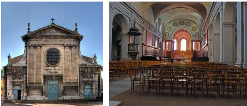
Figure 5.27 : Église Saint-Just (1562 démolition, reconstruction 1662 chœur, 1704 dessin façade Ferdinand Delamonce), Lyon 5 ème (69).
