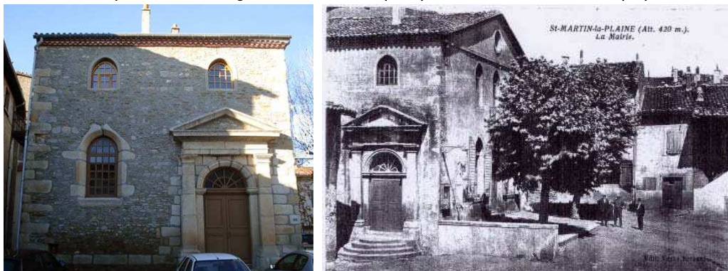
Figure 6.7 : Médiathèque, ancienne église Saint-Martin (XVII e ), Saint-Martin-la-Plaine (42).
