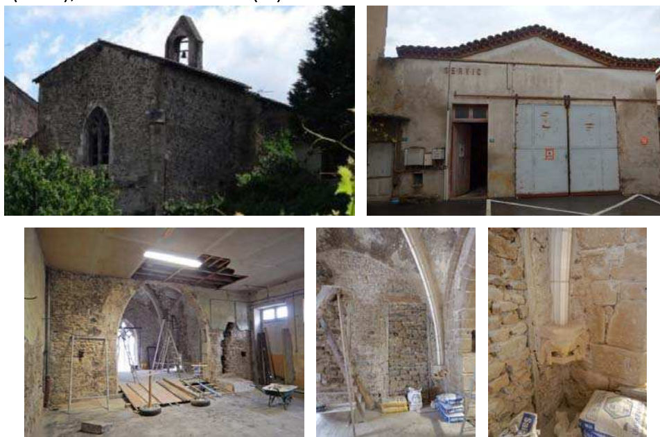
Figure 6.15 : Chantier participatif menée par l'association de la Mémoire pétrébocienne, ancienne église Saint-Pierre (V e -XV e ), Saint-Pierre-de-Bœuf (42).
