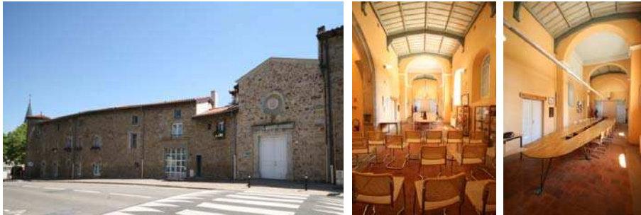
Figure 6.20 : Salle du conseil municipal et des mariages, ancienne église Saint-André (XIV e -XVII e ), Villars (42).
