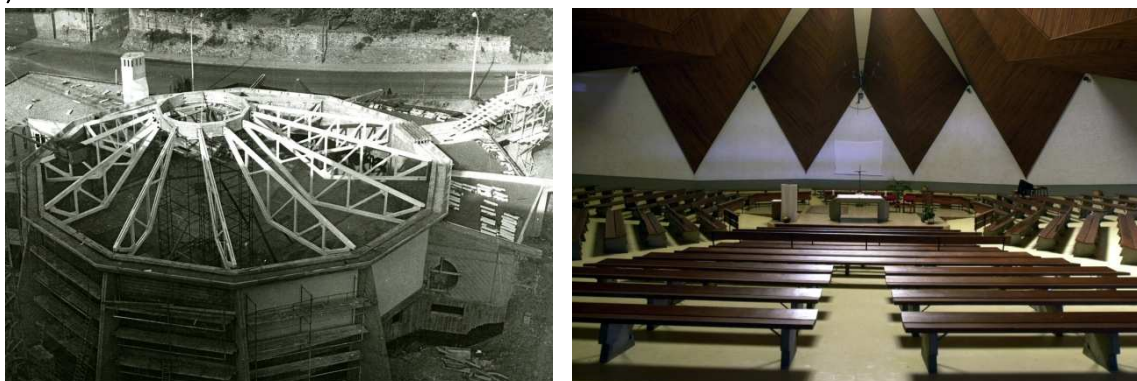
Figure 5.92 : Chantier de l'église Sainte-Anne-de-Ménival (1964-1968, George et Paul Curtelin), Lyon 5 ème (69).
