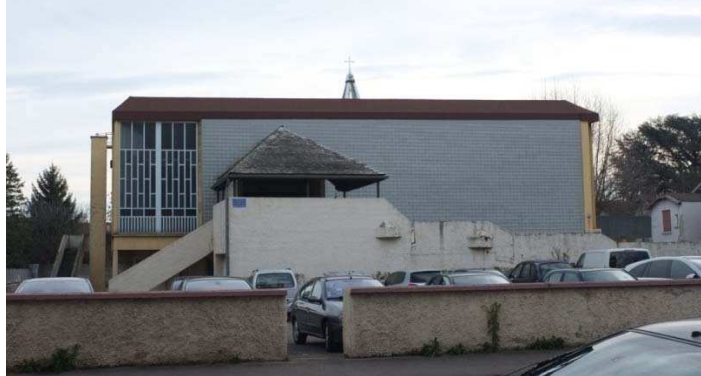
Figure 9.51 : Église Notre-Dame-de-l'Espérance, façade ouest et lanterneau depuis la rue Flachet.
