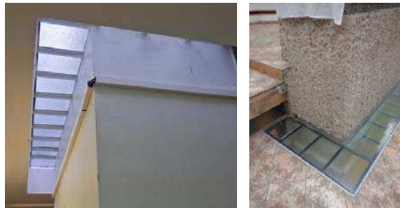
Figure 9.47 : Église Notre-Dame-de-l'Espérance, vues de la pierre de l'autel et du joint creux vitré.
