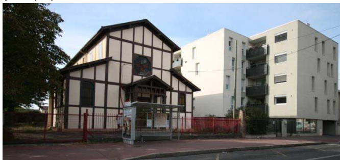
Figure 4.51 : Église Notre-Dame-des-Bruyères (1933), construite par la Société de soie artificielle pour son personnel, Décines-Charpieu (69).
