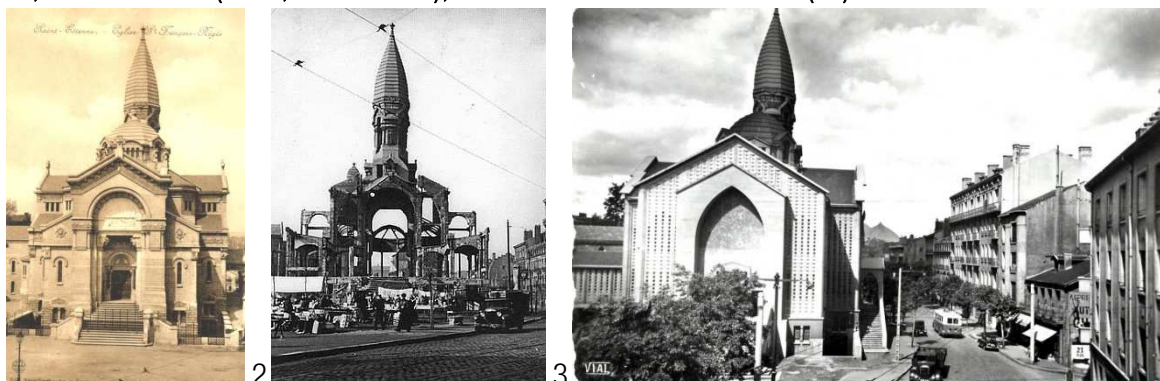
Figure 5.51 : Église Saint-François-Régis (1910, Paul Noulin-Lespès), avant et après le bombardement de 1944, reconstruction (1951, Edouard Hur, IMH et Label XX e Saint-Étienne (42)).
