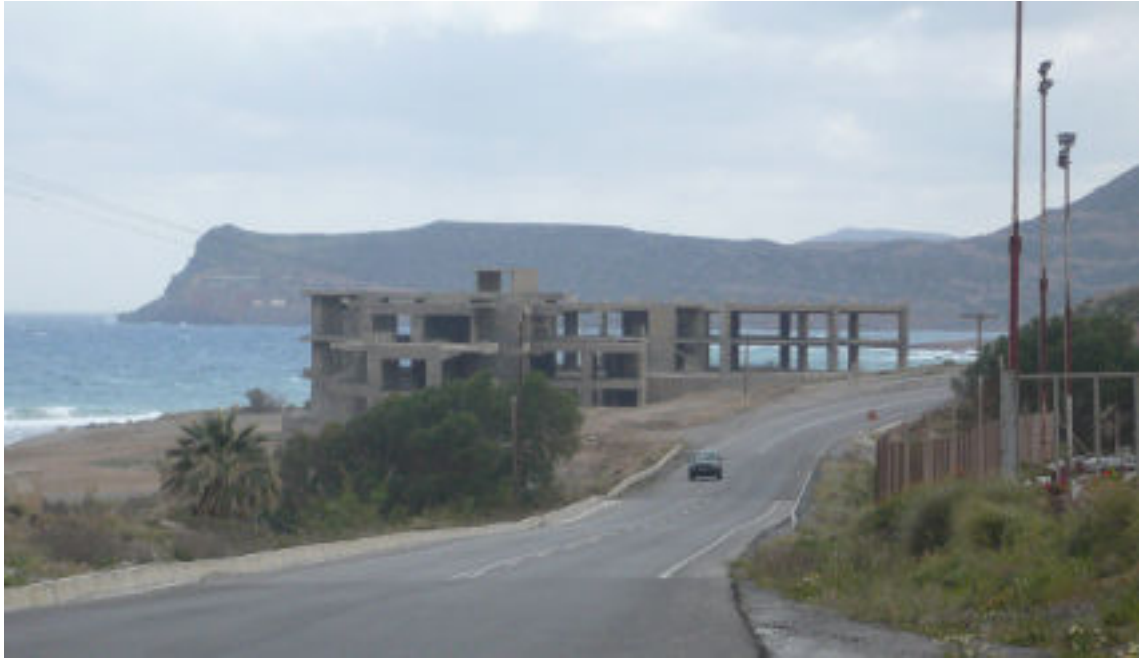
Figure 40 : Un exemple de verrue paysagère le long d'une plage de la baie de Sitia : une structure en béton armé d'un hôtel jamais terminé (source : auteur).
