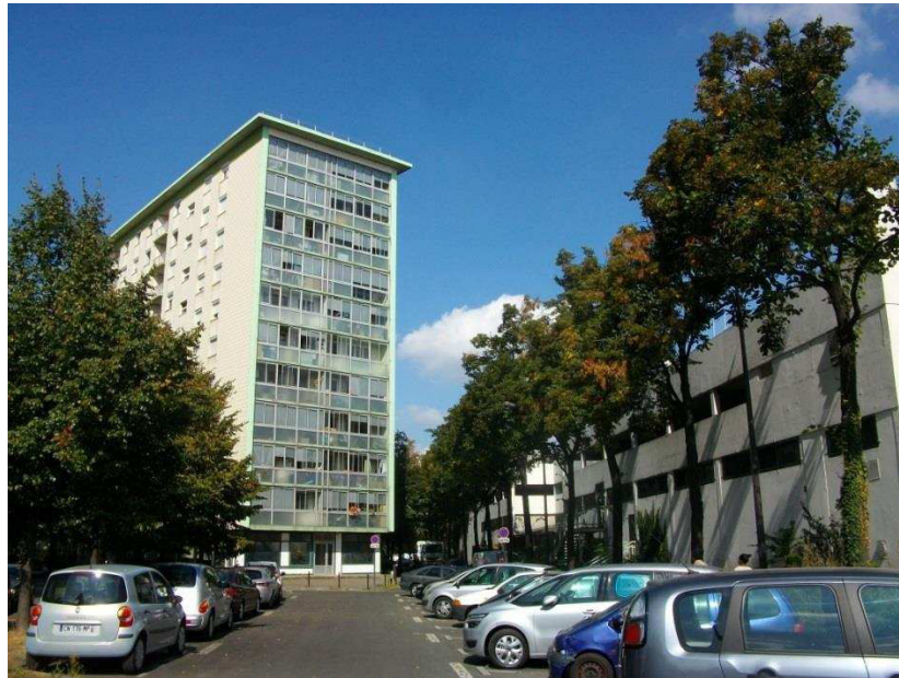
Photographie 2.19 - Quartier Paul Bourget : immeuble, stationnement en surface et parking privé
