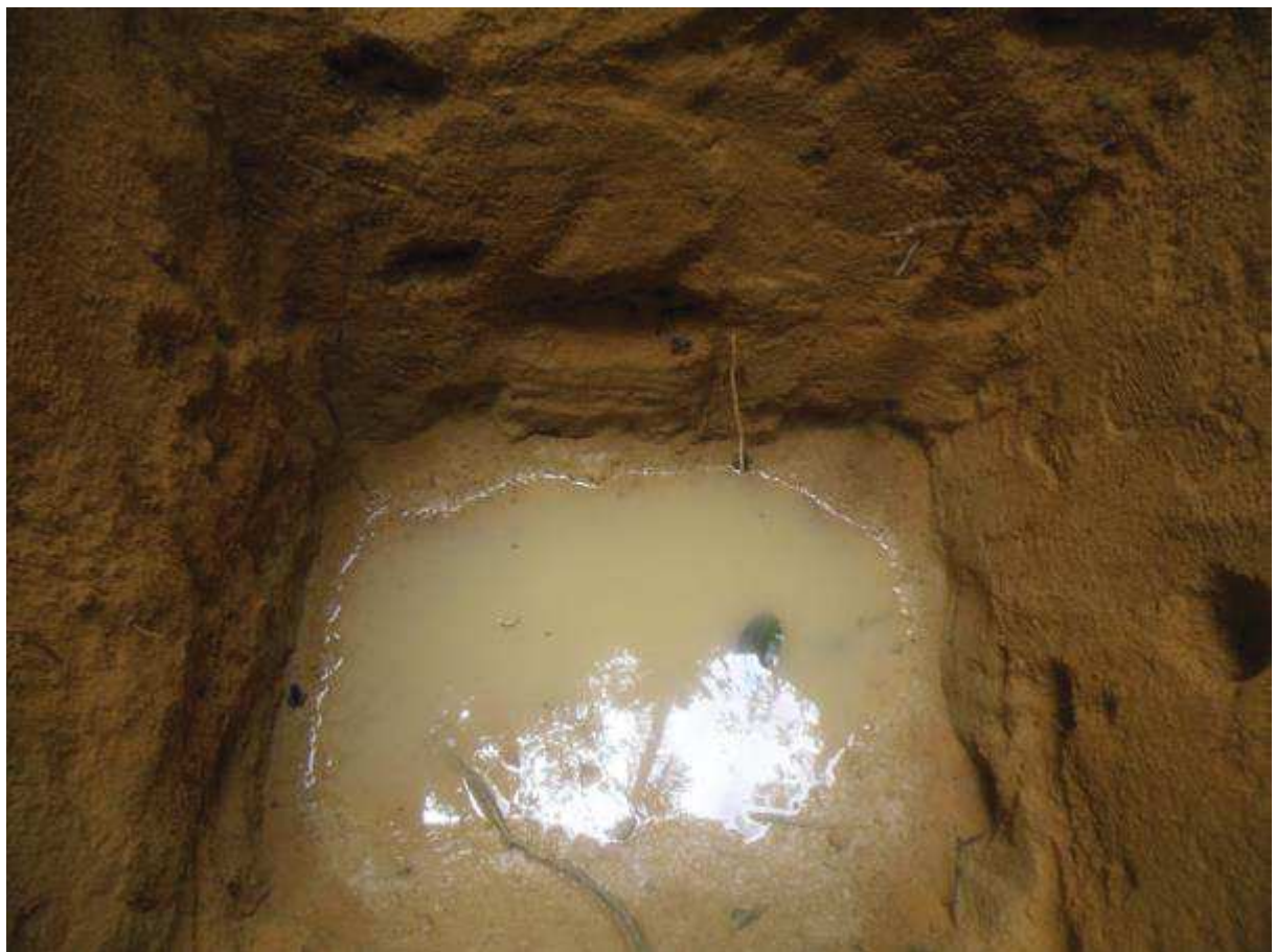
Photo 1-8 : fond de la fosse 1 le lendemain d'une pluie modérée d'environ 1 heure
