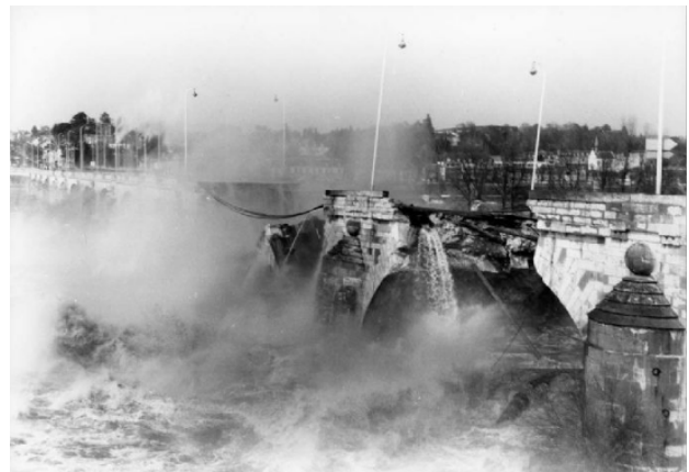
FIGURE 1-3 – L'effondrement du Pont Wilson à Tours en 1978. Photographie : A. Arsicaud ( http://archives.cg37.fr ).
