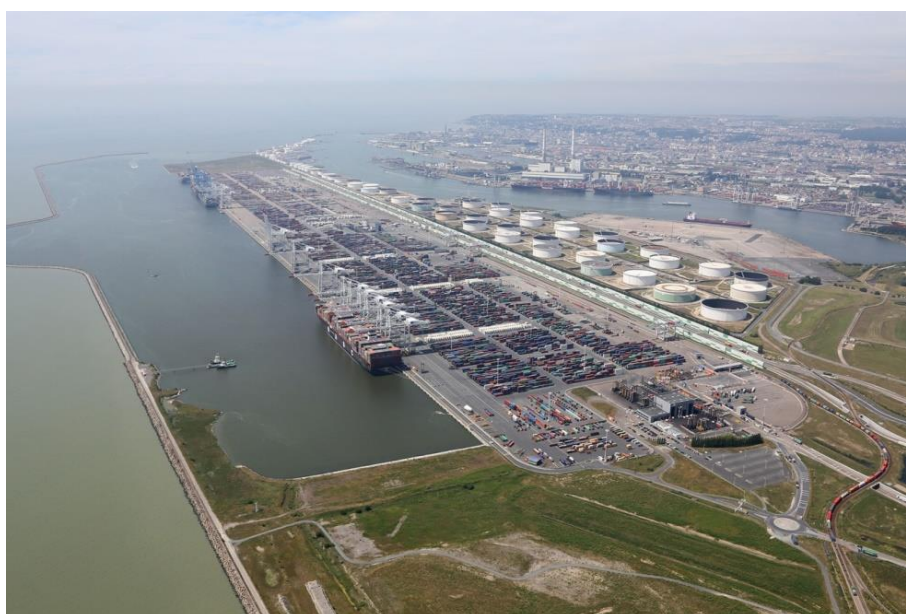
Figure 78 – Vue aérienne depuis l’est de la digue de Port 2000
