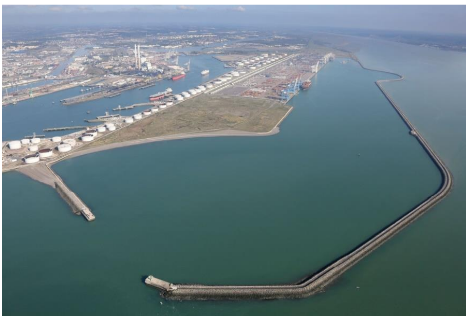
Figure 76 – Vue aérienne depuis l’ouest de la digue de Port 2000
