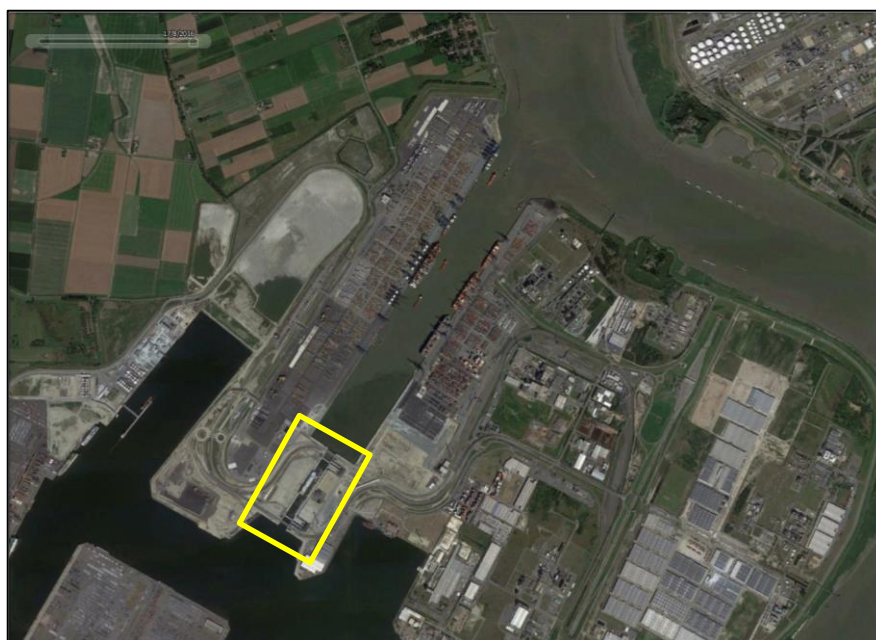
Figure 89 – Photographie aérienne de 2016 : écluse du Deurganckdok fonctionnelle
