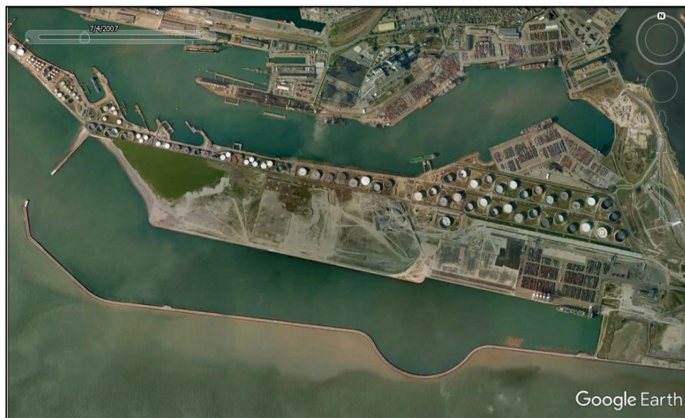
Figure 75 – Photographie aérienne de 2007 : travaux achevés et début de l'aménagement des quais
