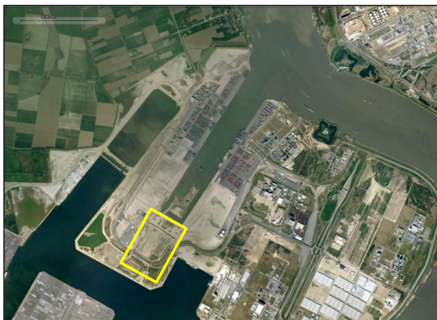
Figure 85 – Photographie aérienne de 2007 : poursuite des travaux
