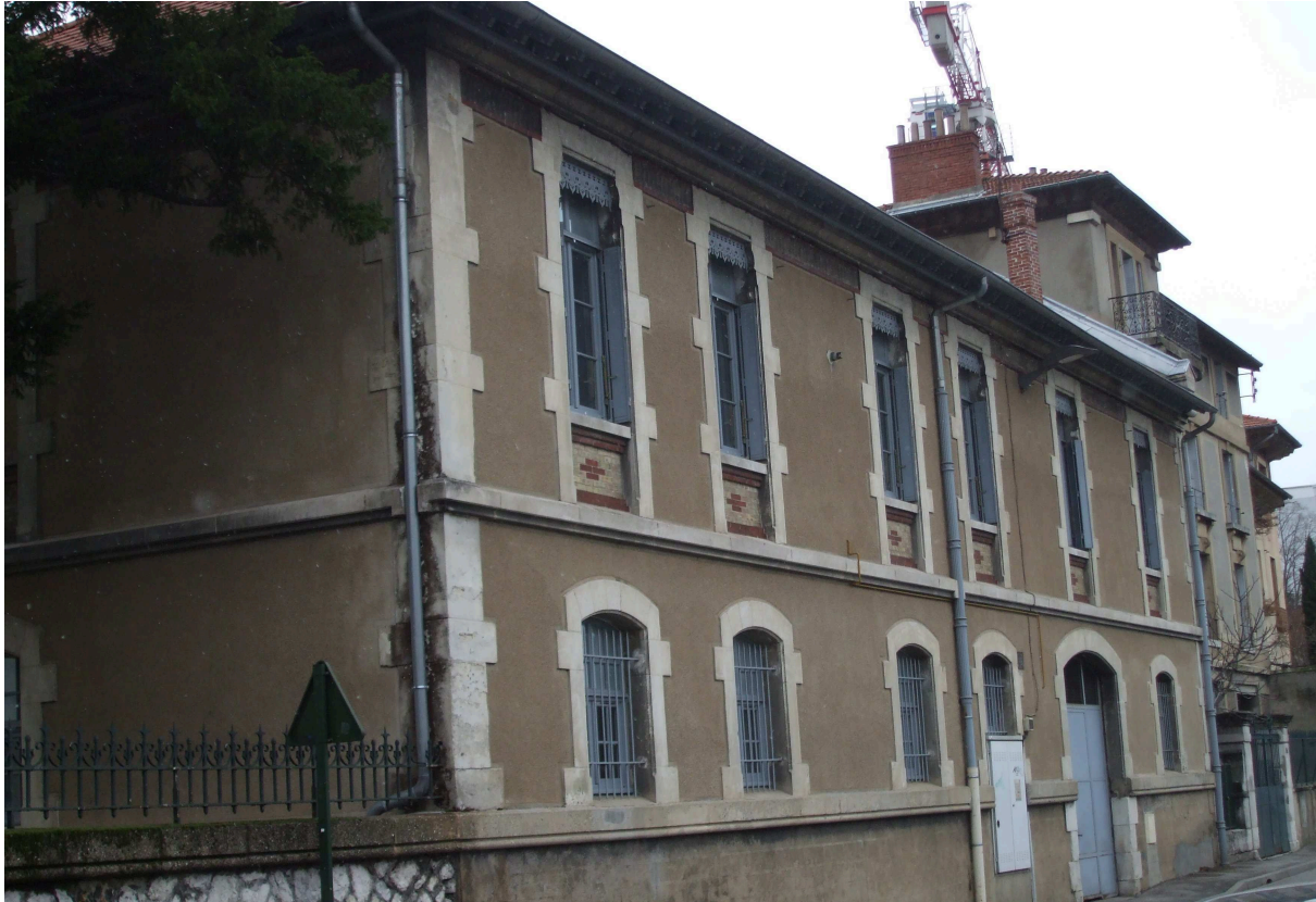
Illustration 81 – Collège de jeunes filles : façade ouest , sur l'avenue Maurice Faure (Cliché J.S. Gauthier, 2013)
