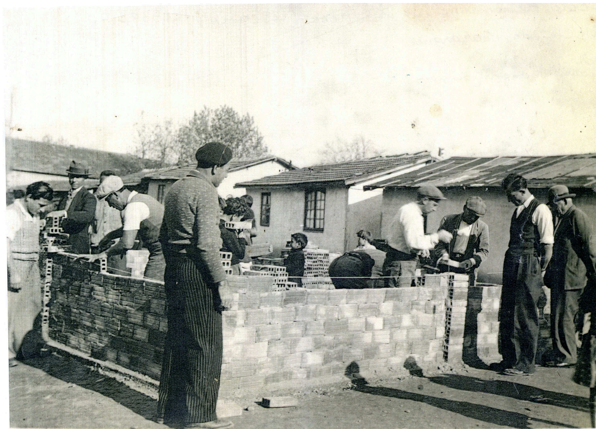
Illustration 16 - Construction de l'école arménienne Ste-Anne, quartier St-Jérôme. (Collection ARAM)
