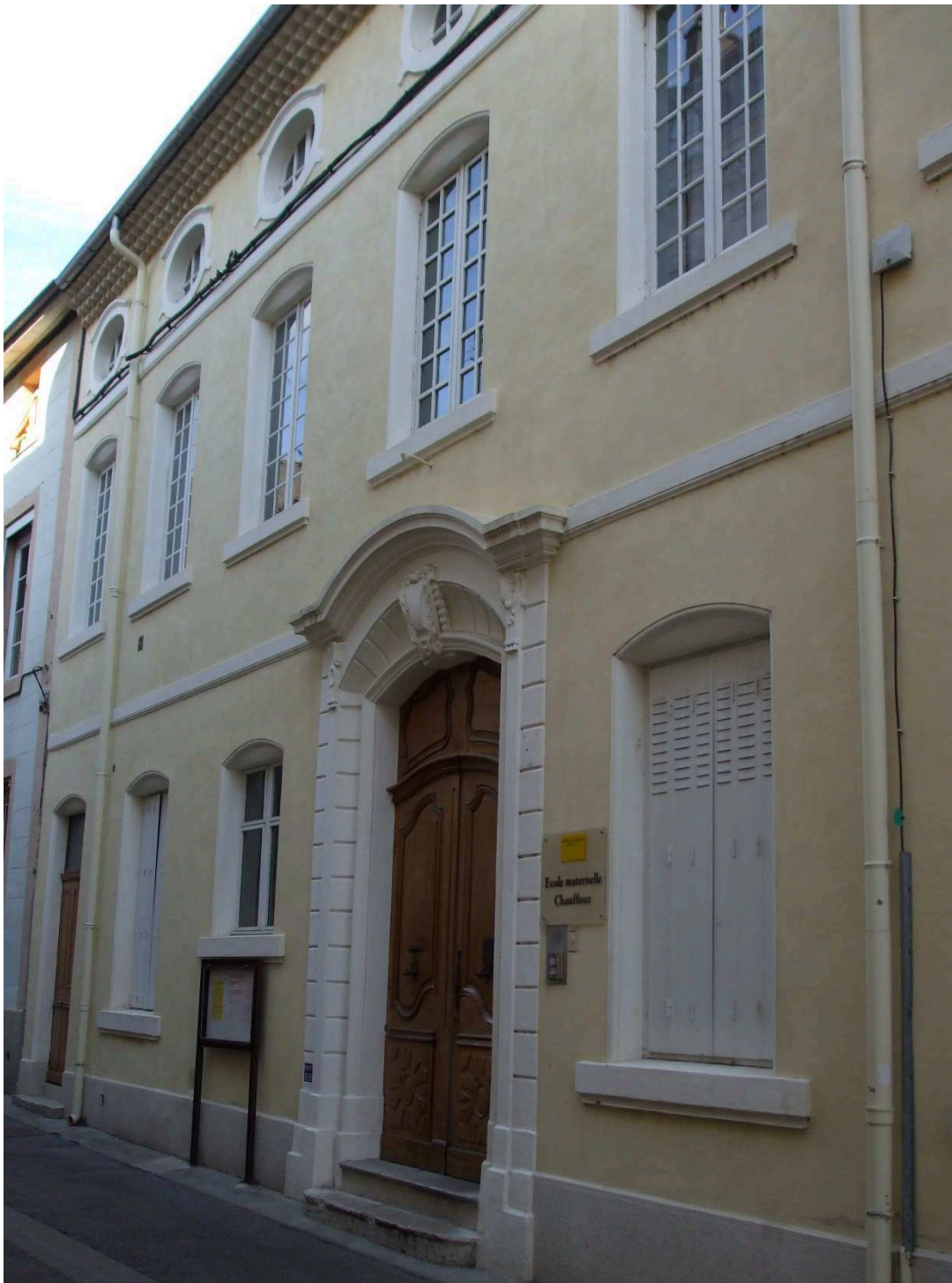
Illustration 56 – Entrée principale de l'école maternelle de la rue Chauffour (cliché J.S. Gauthier, 2012)
