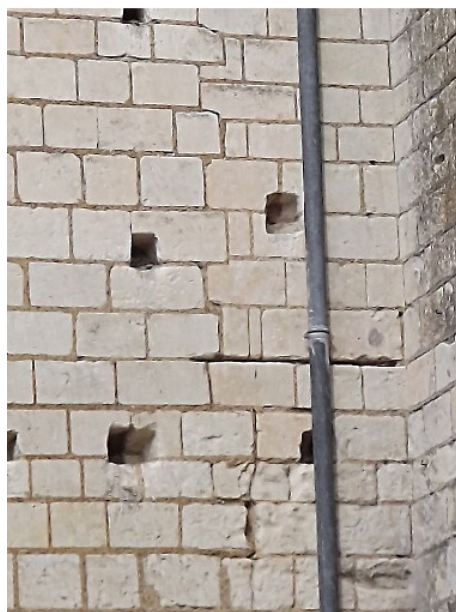
Figure 91. Détail du gouttereau sud de la nef.
