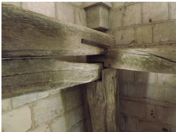
Figure 111. Assemblée des pièces de charpente à l'angle supérieur nord-est du beffroi.
