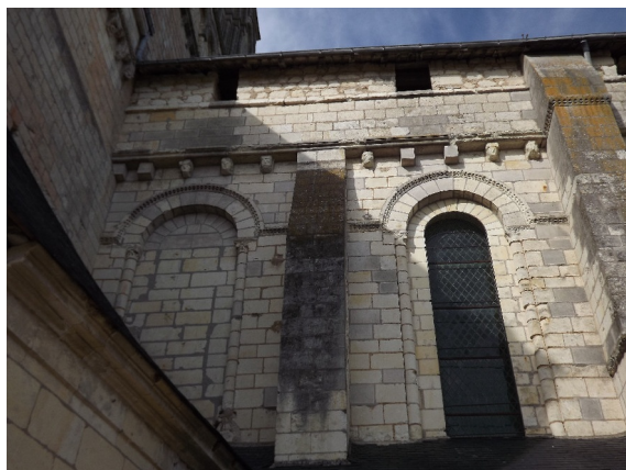
Figure 44. Élévation sud du chœur.
