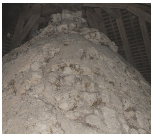
Figure 113. Extrados de la voûte du clocher.
