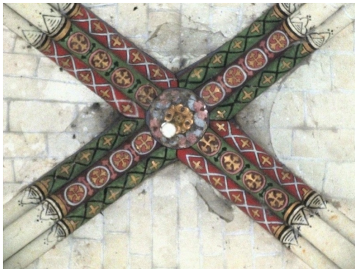
Figure 220. Clef de voûte de la nef, travée occidentale.
