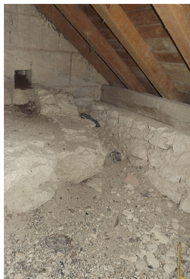
Figure 58. Comble du croisillon sud ; raccordement du gouttereau au mur du clocher.
