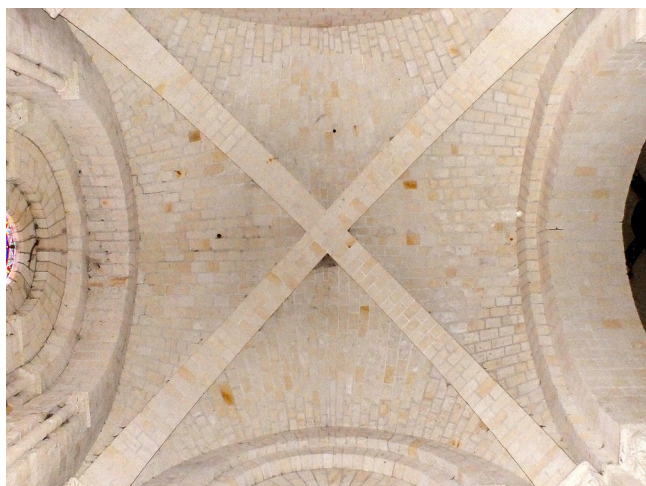
Figure 63. Voûte du croisillon sud.
