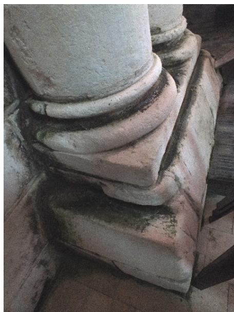
Figure 42. Socle et base de la colonne engagée à l'entrée de l'abside, au nord.
