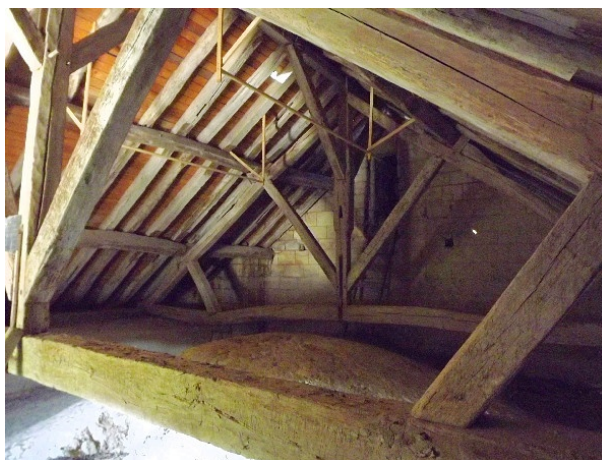
Figure 71. Comble du croisillon nord.
