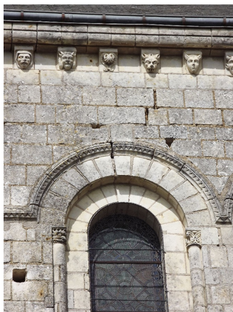
Figure 89. Fenêtre sud de la nef.
