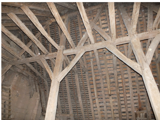
Figure 35. Charpente du chœur, vue vers le nord-ouest.
