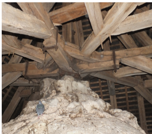
Figure 108. L'enrayure de la charpente du clocher.
