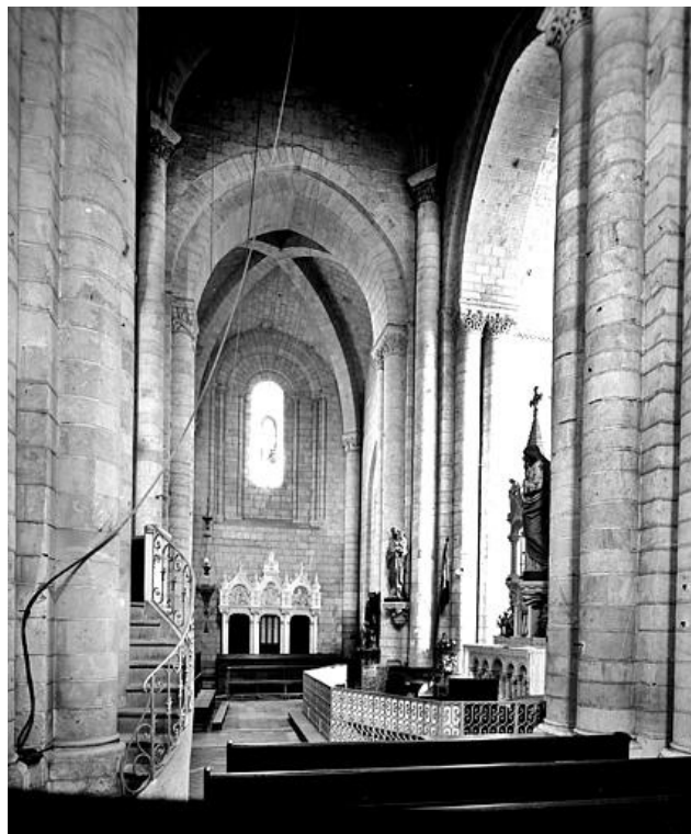
Figure 144. Vue intérieure du transept vers le nord. Estève, Georges.
