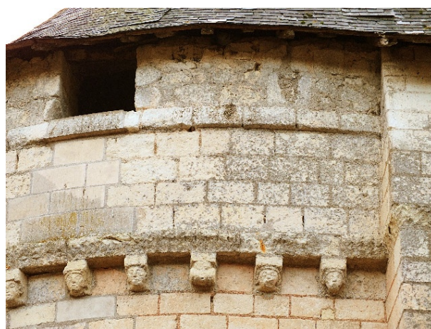
Figure 38. Exhaussement de l'abside, côté nord.
