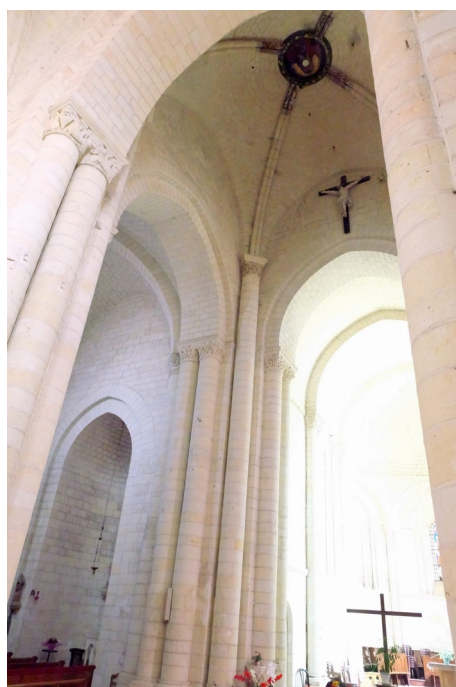
Figure 74. Vue de la croisée depuis la nef.
