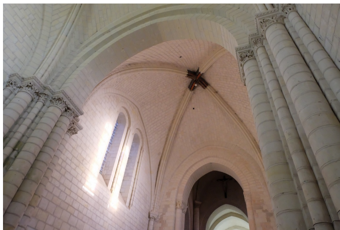
Figure 85: La travée orientale de la nef.
