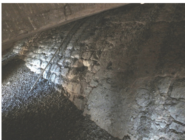
Figure 47. L'extrados du berceau qui recouvre le chœur, et du cul-de-four de l'abside (ce dernier est à droite).
