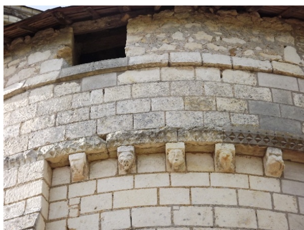
Figure 37. La double surélévation de l'abside, prétendue être un aménagement défensif.
