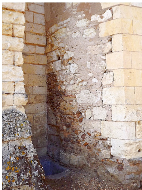
Figure 43. Arrachement de l'ancienne absidiole orientée sud, actuellement sacristie.
