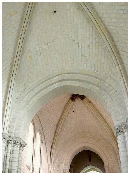
Figure 97: Le doubleau central de la nef, vu de l'ouest.
