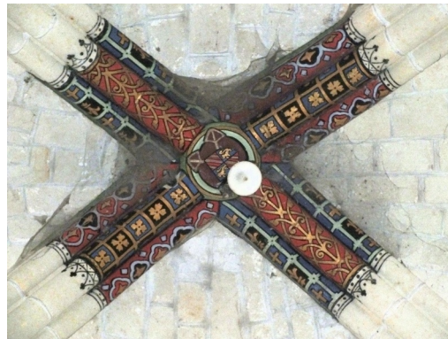
Figure 221. Clef de voûte de la nef, travée orientale.
