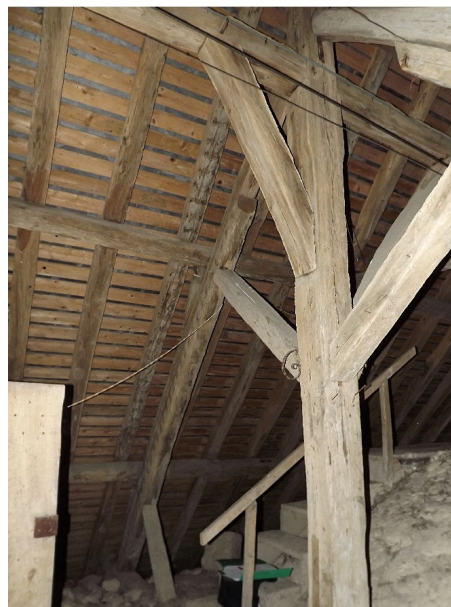
Figure 87. Comble de la nef : ferme.
