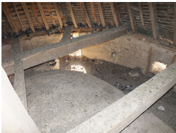
Figure 39. Exhaussement de l'abside, vu du comble du chœur.
