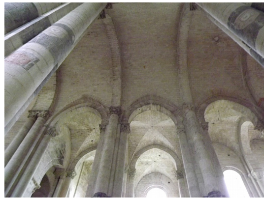
Figure 24: Église priorale de Cunault : la voûte en berceau à pénétrations du chœur.
