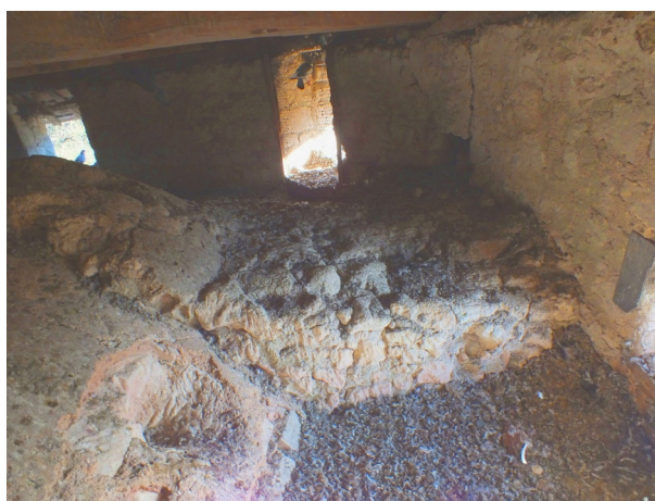
Figure 48. L'éperon qui contrebut le cul-de-four recouvrant l'abside vers l'est.
