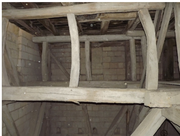
Figure 112. Salle du 1 er étage du clocher : pièces de charpente supportant l'étage des cloches.
