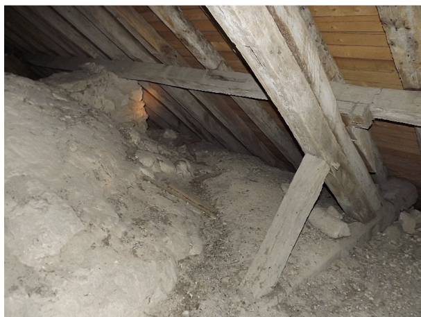
Figure 86. Comble de la nef : pile supportant la panne inférieure.
