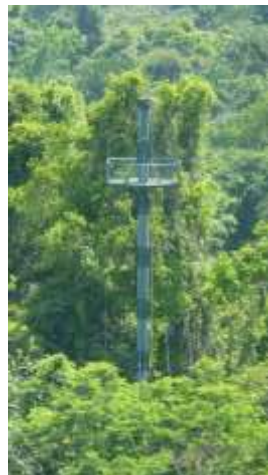
Figure 1 : L'un des trois pylônes du Copas. Source : photo personnelle, 2010.
