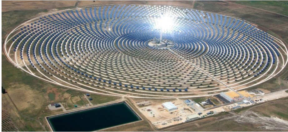
Figure 11 Centrale GEMASOLAR : 17MWe, 80GWh/an, stockage 15h (deux cuves sels fondus)
