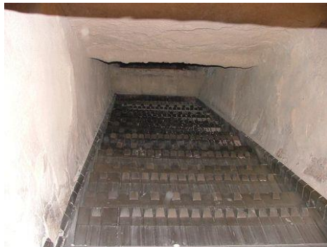
Figure 37 Four à grille en gradins (Ecovalor.net) et schéma d'installation d'une UVE (tiru.fr)
