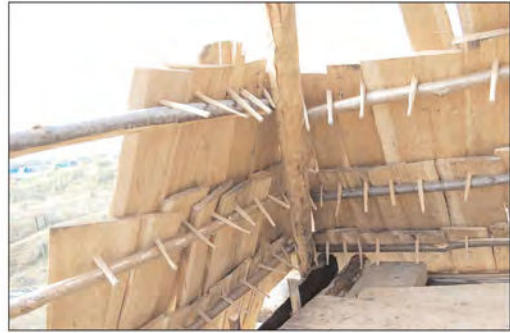
Fig. IV-7 Réalisation d'une toiture en bardeaux de chêne sur le site d'Orville à Louvres (2010 et 2011)
