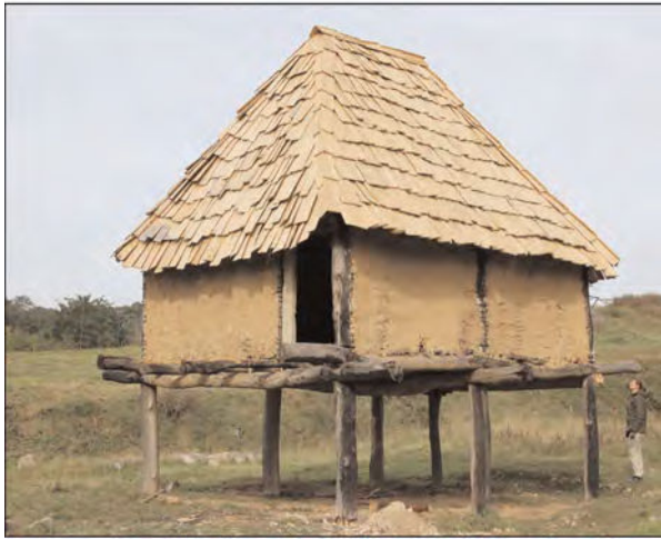
Fig. IV-7 Réalisation d'une toiture en bardeaux de chêne sur le site d'Orville à Louvres (2010 et 2011)
