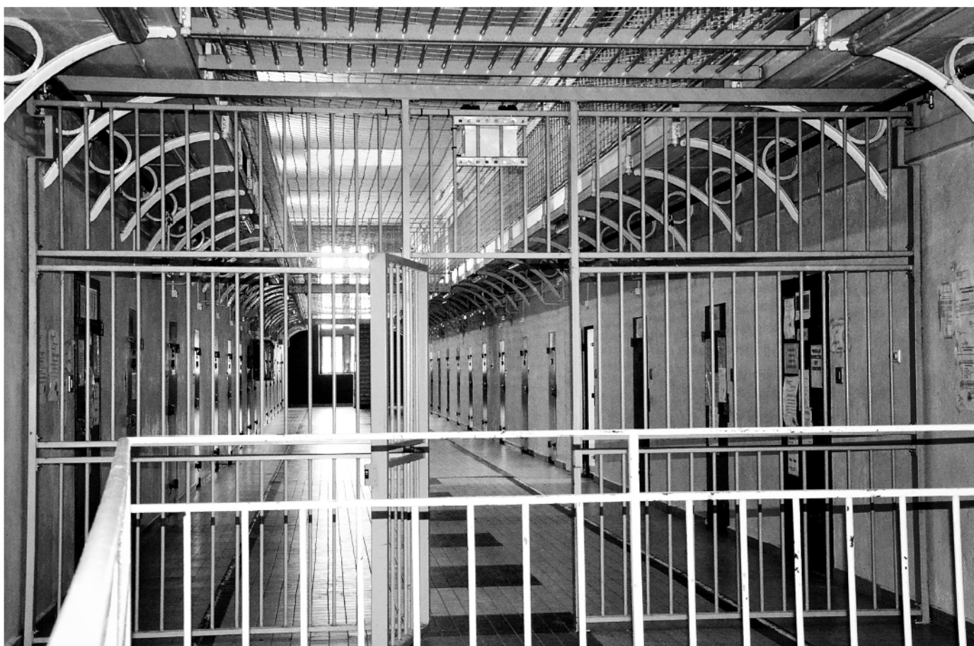
Figure 2 : Grille d'entrée d'un quartier de la détention (Aline Chassagne, 2017)
