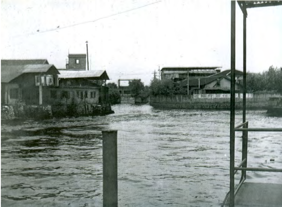
Figure 1-117 Avant la construction du quartier : méandre de Panjia en 1980. XU Xixian, A changing Shanghai , Shanghai People's Fine Arts Publishing House, 2005.
