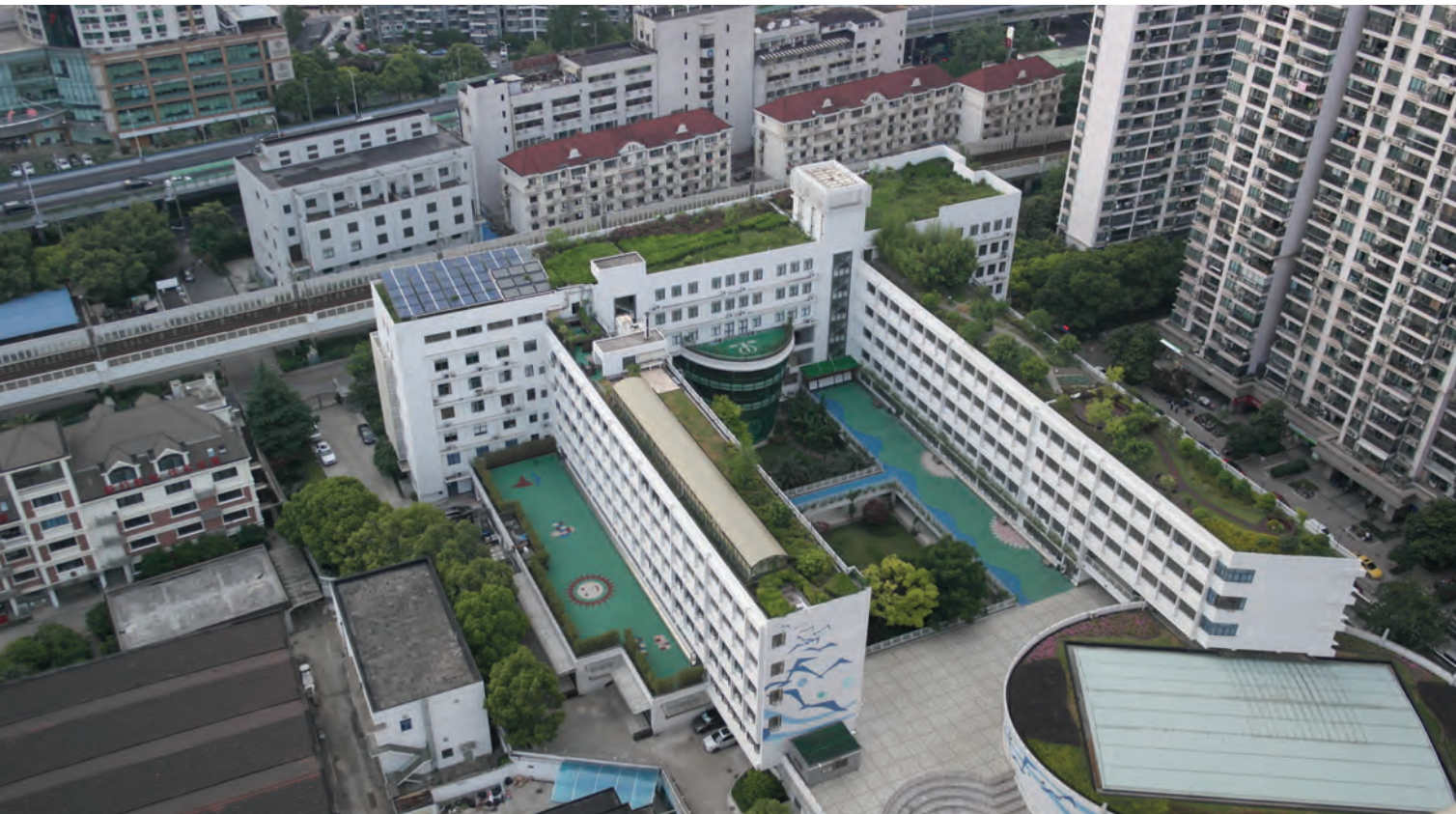
Vue aérienne de l'école
