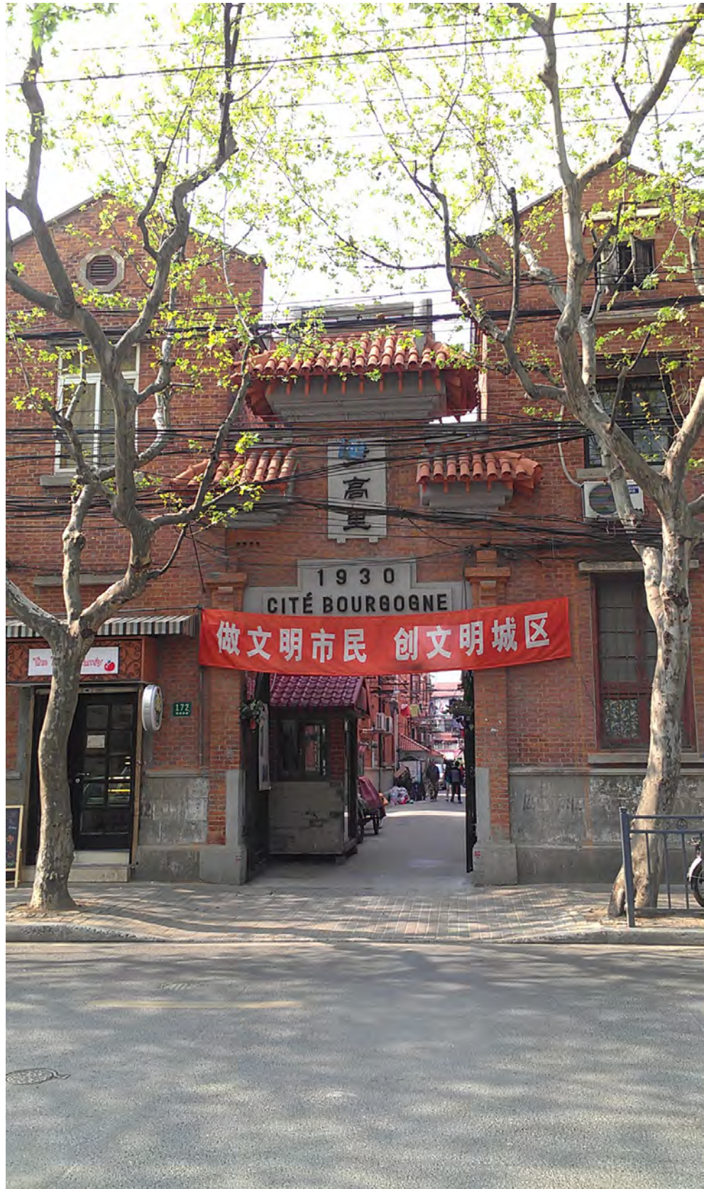
Figure 1-12 Entrée sud, style de pailou
