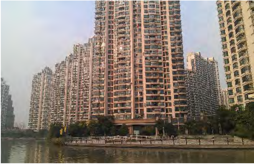
Figure 1-138 Photo de jour sur le côté sud du quartier.
