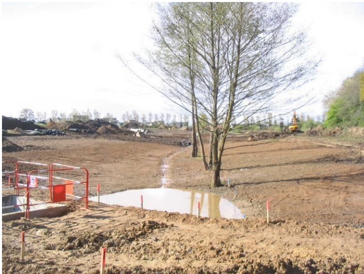
Photo 76 : Pendant l'aménagement du Vallon des Saules (Bazin 2005) - A gauche, terrassement pour l'écoulement et la rétention dans des bassins successifs, à droite, fosse pour analyse de la composition du sol.
