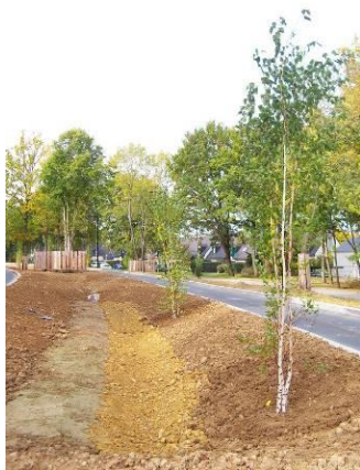
Photo 141 : noues centrales sur l'avenue Germaine Tillon pendant les travaux et après (El Moualy-2017 – Bazin 2013)
