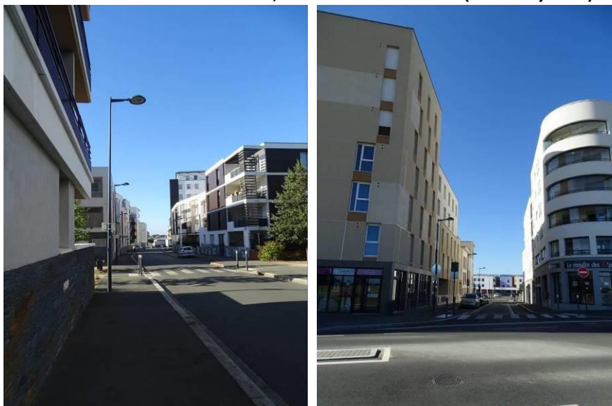
Photo 108 : rue du Haut Rocher, boulevard Jean Moulin (El Moualy 2018)
