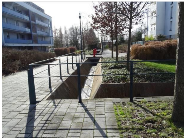
Photo 92 : large fossé minéral en cœur d'îlot dans la Zac des Rives du Blosne (El Moualy 2017)
