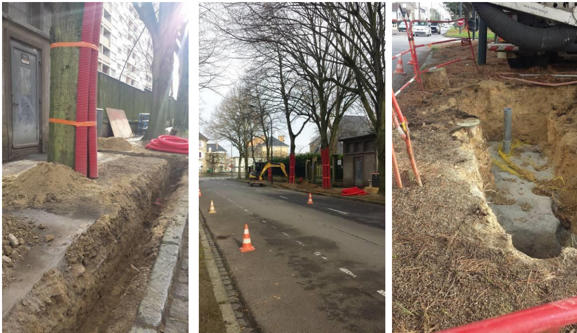
Photo 123 : travaux rue du Général Nicolet et boulevard Albert 1er (El Moualy 2017)
