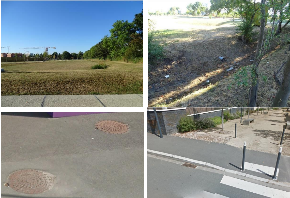
Photo 148 : éléments d'aménagement pour l'évacuation des eaux de ruissellement au Plateau des Capucins (El Moualy 2017)
