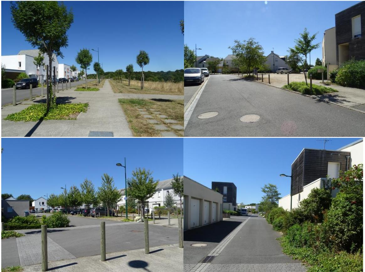
**Photo 155 : profils de voiries aux Perrières, tout au même niveau avec des subtilités de nivellement (El Moualy 2017)**
