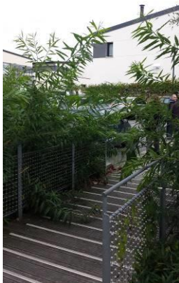
Photo 84 : Arbustes derrière un garde-corps qui envahit la passerelle (El Moualy 2016)
