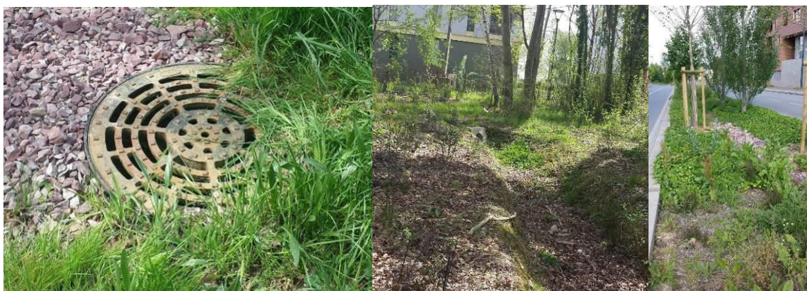
Photo 48 : noues dans le secteur Maisons dans les bois et fossé boulevard Jules Maniez (El Moualy 2017)
