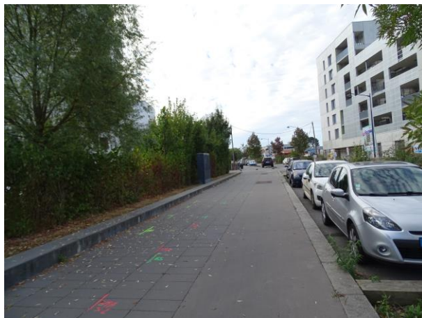
Photo 158 : Voirie à la Courrouze, à gauche, même niveau mais partie piétonne protégée par des bordures hautes, à droite, trottoir surélevé et massifs d'arbustes surélevés. (El Moualy 2017)
