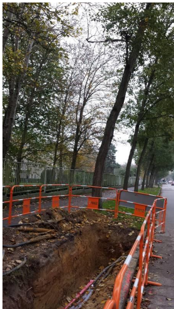
Photo 21 : travaux successifs sur les réseaux au pied des arbres entre 2015 et 2017 (El Moualy)
