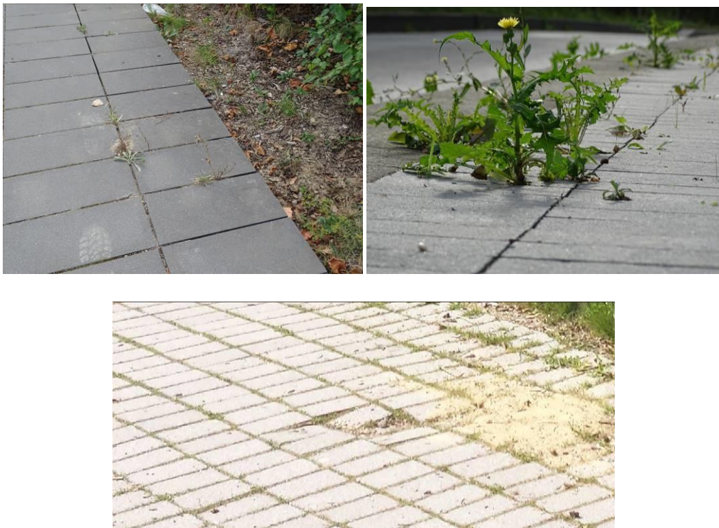
Photo 63 : exemple de pavages à joints enherbés (El Moualy, 2017)
