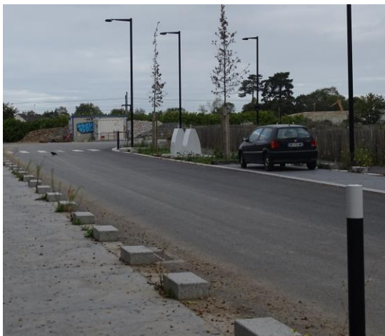
Photo 158 : Voirie à la Courrouze, à gauche, même niveau mais partie piétonne protégée par des bordures hautes, à droite, trottoir surélevé et massifs d'arbustes surélevés. (El Moualy 2017)
