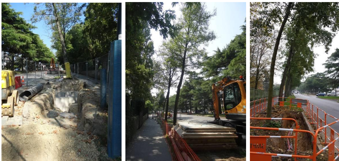
Photo 124 : travaux avenue de Bréquigny (El Moualy 2017)
