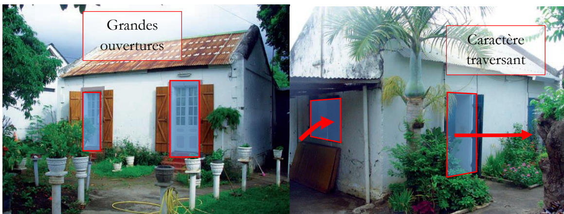
Figure 1.5 : Construction locale de l'île de La Réunion en béton sous tôle (Giovannoni, 2011)
