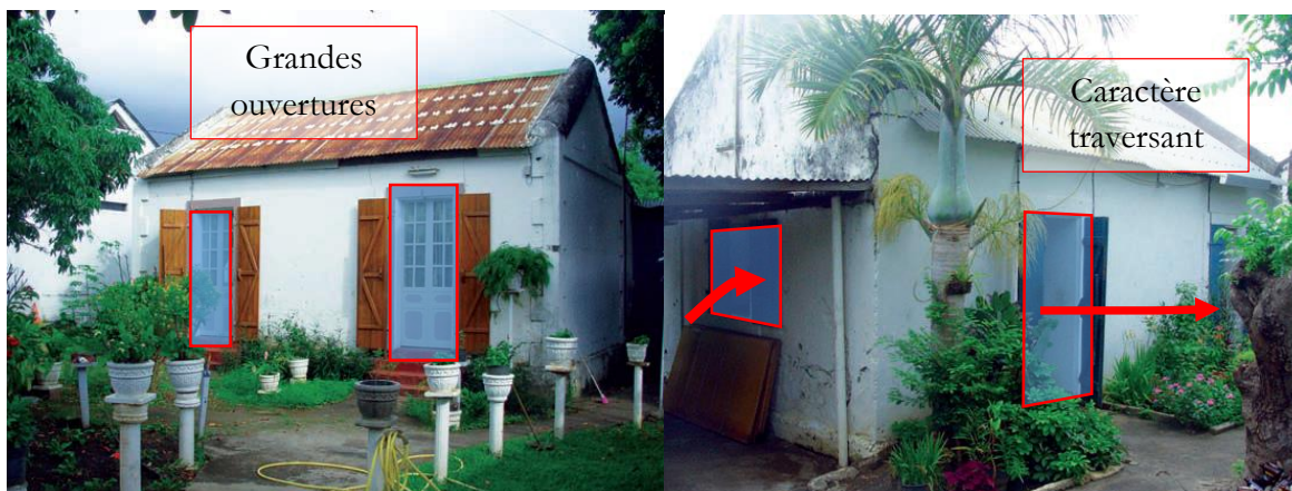
Figure 1.5 : Construction locale de l'île de La Réunion en béton sous tôle (Giovannoni, 2011)
