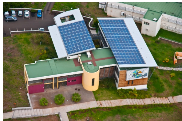
Figures 3.1a et 3.1b : ENERPOS : Façade Sud-Ouest équipée de protections solaires. Le bâtiment dispose de toitures PV orientées Nord et Sud avec un angle de 9°. Les données de consommation du bâtiment sont utilisées pour la simulation
