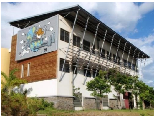
Figures 3.1a et 3.1b : ENERPOS : Façade Sud-Ouest équipée de protections solaires. Le bâtiment dispose de toitures PV orientées Nord et Sud avec un angle de 9°. Les données de consommation du bâtiment sont utilisées pour la simulation
