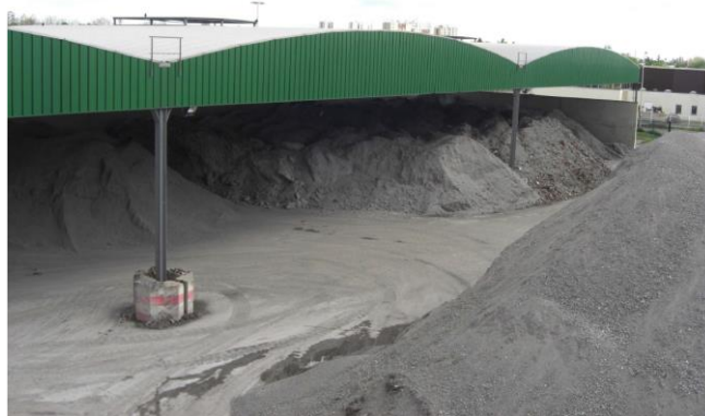
Figure 5. Exemple de stockage des MIDND dans une IME.
