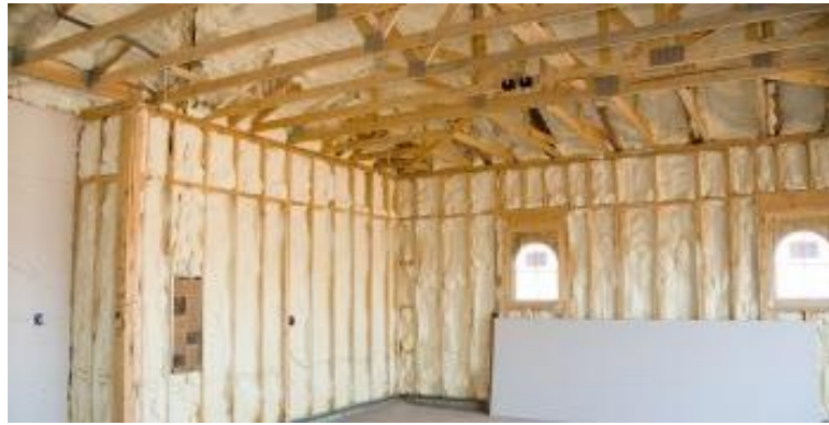
Fig. 5 – Isolation d'un bâtiment avec mousse polymère
