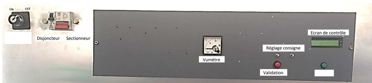
Figure 2.29 : Tableau de commande du système électrique
