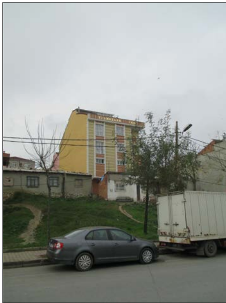
Un immeuble type apartkondu surplombe deux petites maisons de gecekondu . Deux formes architecturales reflètent de l'évolution du cadre bâti à Güvercintepe.
