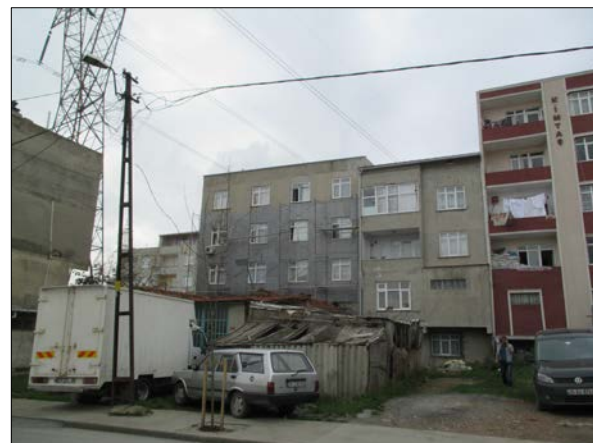
Travaux d'isolation en cours. Les seuls que nous ayons repérés dans ces quartiers.
