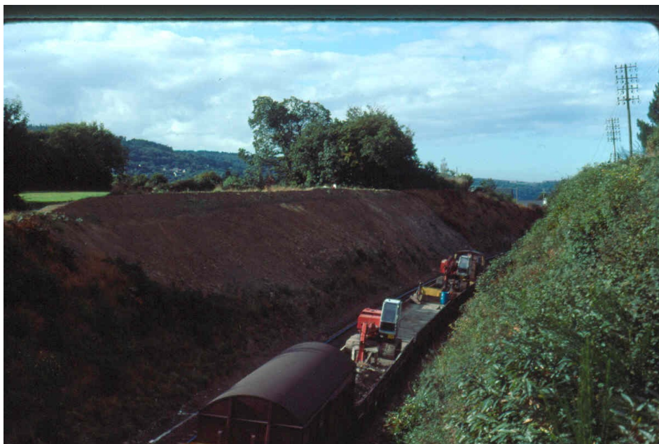
Illustration 7 : reprofilage du talus de chemin de fer à La Forest-Landerneau en 1988.
