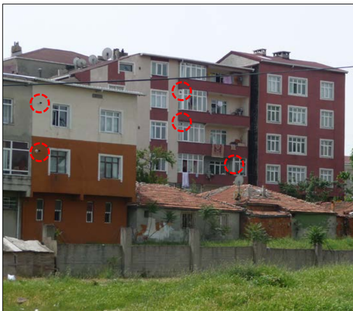
Des gecekondu chauffés au charbon aux immeubles auto-construits équipés de chaudières à gaz dans le quartier Ziyah Gökalp. Crédit : E.A., 17/05/2013
