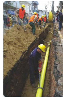
Travaux d'installation du réseau dans un quartier non-identifié.
