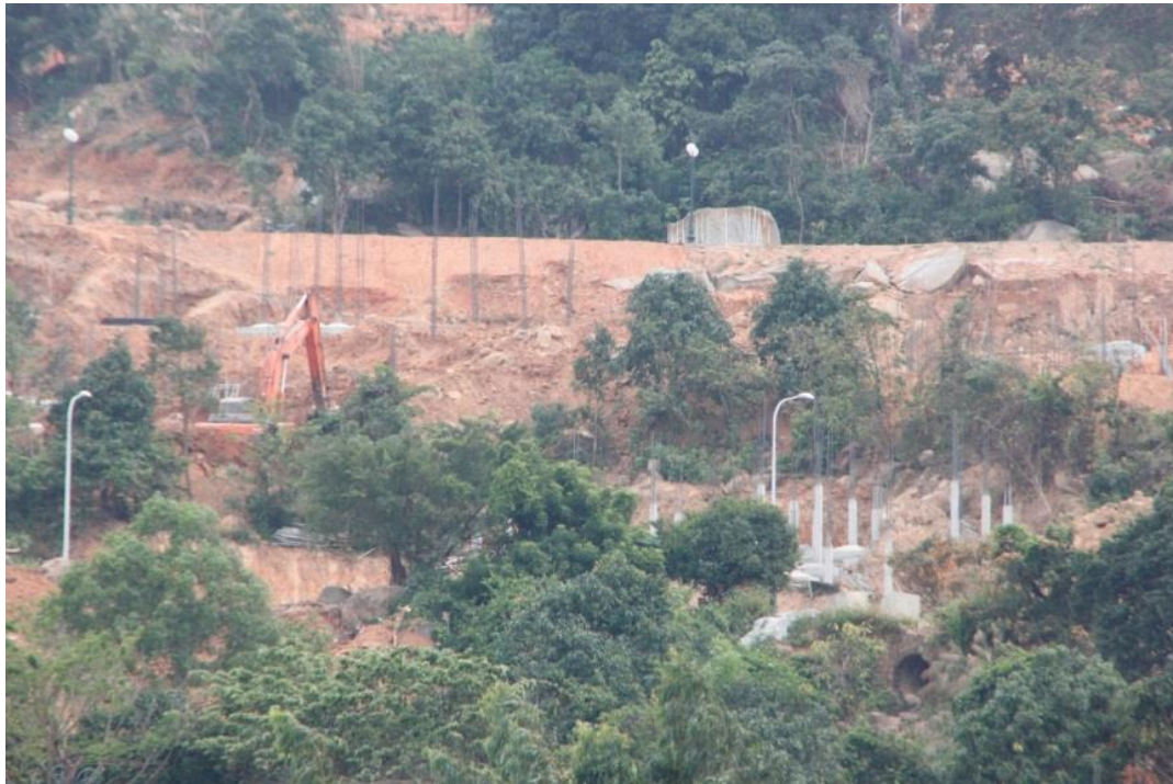
Photo 22: 40 terrains de villa aménagés sans permission sur la montagne Son Trà
